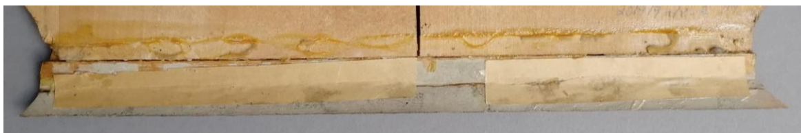
Kuva 24. Haljenneen räystäään vanha korjaus alapuolelta kuvattuna, sekä seinäosan liimasaumasta jääneet ruskeat liimajäljet katon alapinnassa.
