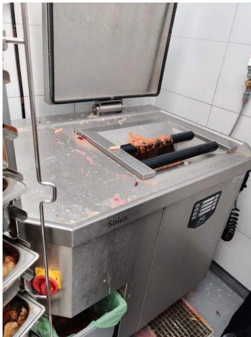
Kuva 12. Keittiön biojätteen jauhatuslaite, Rendisk Solus Eco-laite.
