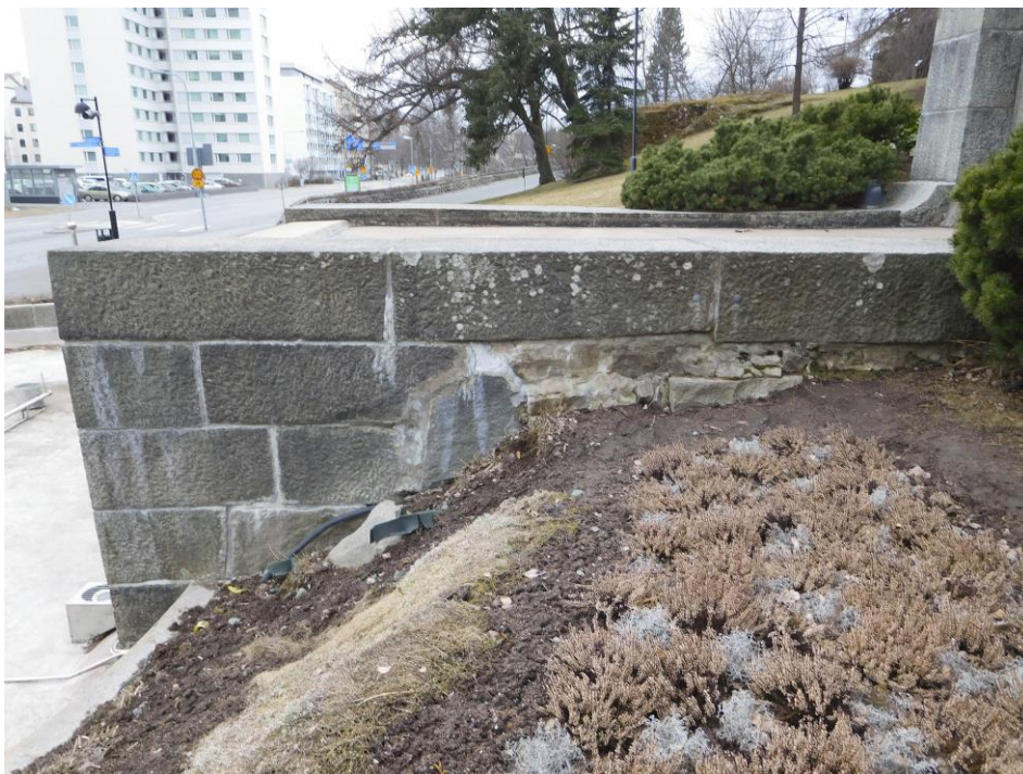
Kuva 14. Keskimmäisen altaan reunakivet. Maan voimakkaan kaartumisen kohdalla näkyy eri muotoisia kiviä muurauksessa.
