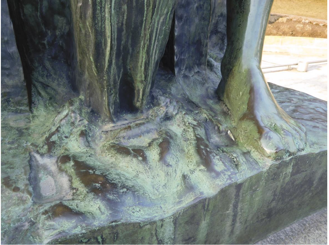
Kuva 24. Isä ja poika -veistoksen jalustassa sekä pojan jalkapöydässä patina on kulunut luultavasti ihmisten koskettelun seurauksena.
