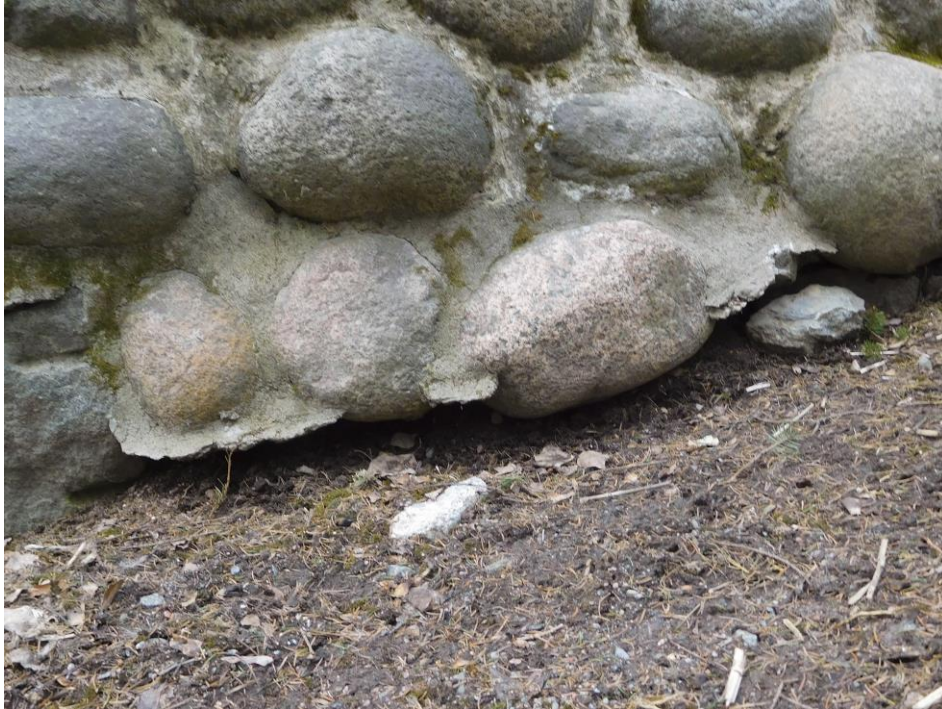
Kuvat 13. Maa valuu ylimmän altaan muurauksen alta pois.
