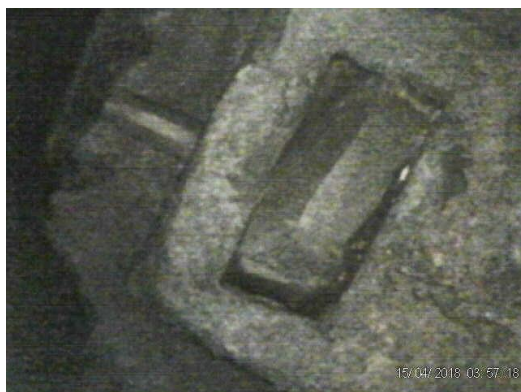
Kuva 18. Endoskooppikameralla saatu kuva Pohjanneidon sisällä olevasta valukappaleiden liitoksesta.
