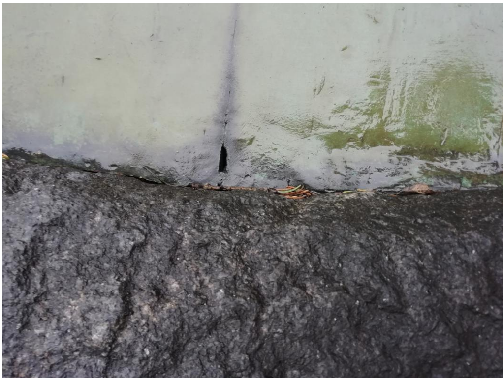
Kuva 20. Pohjanneidon pronssijalustan alareunassa oleva pieni halkeama saumassa.
