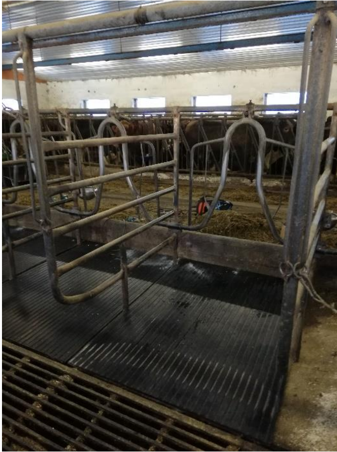
KUVA 9. Parsimattojen asennus (Holmström 2020-03-23).
