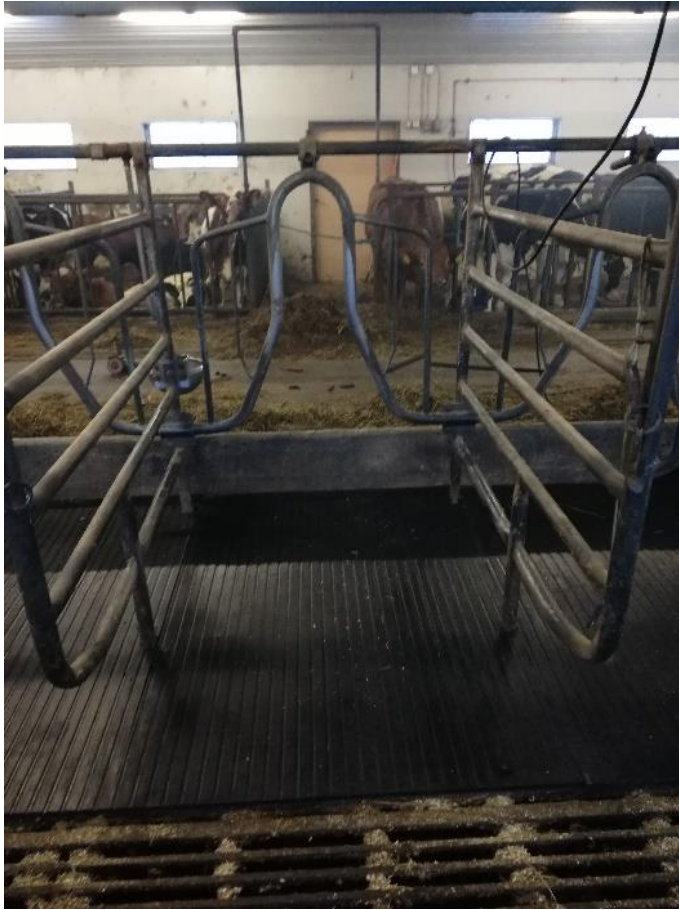
KUVA 10. Parsimattojen asennus (Holmström 2020-03-23).
