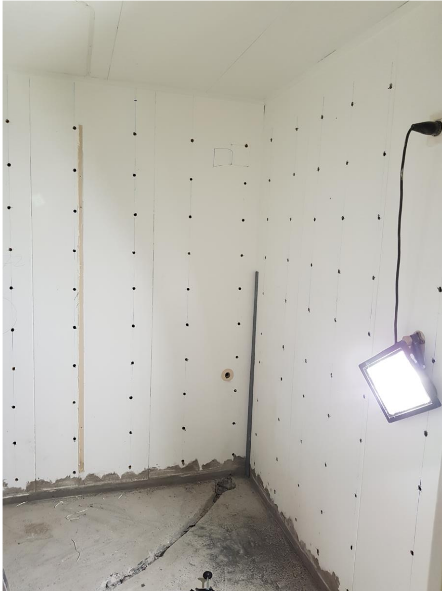
Kuva 8. Olemassa oleva seinärakenne on rei'itetty RT84-11093 -kortin ohjeistuksen mukaisesti. (Ville Kärkkäinen 2020.)
