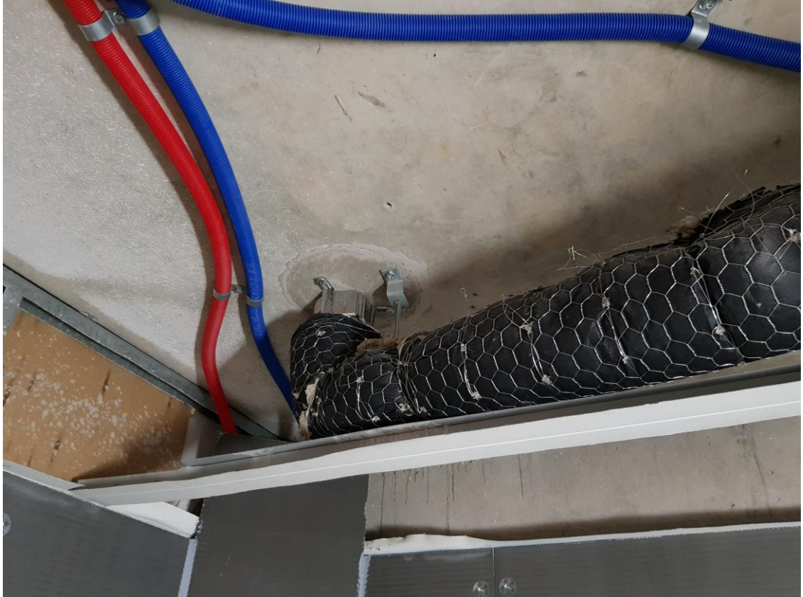
Kuva 11. Uusi viemäri on sijoitettu alaslaskettuun kattoon. Viemärin alapuolella on näkyvissä valkoinen kaista, joka on alkuperäisen peltirungon katon jäykistävä rankaosa. (Ville Kärkäinen 2020.)
