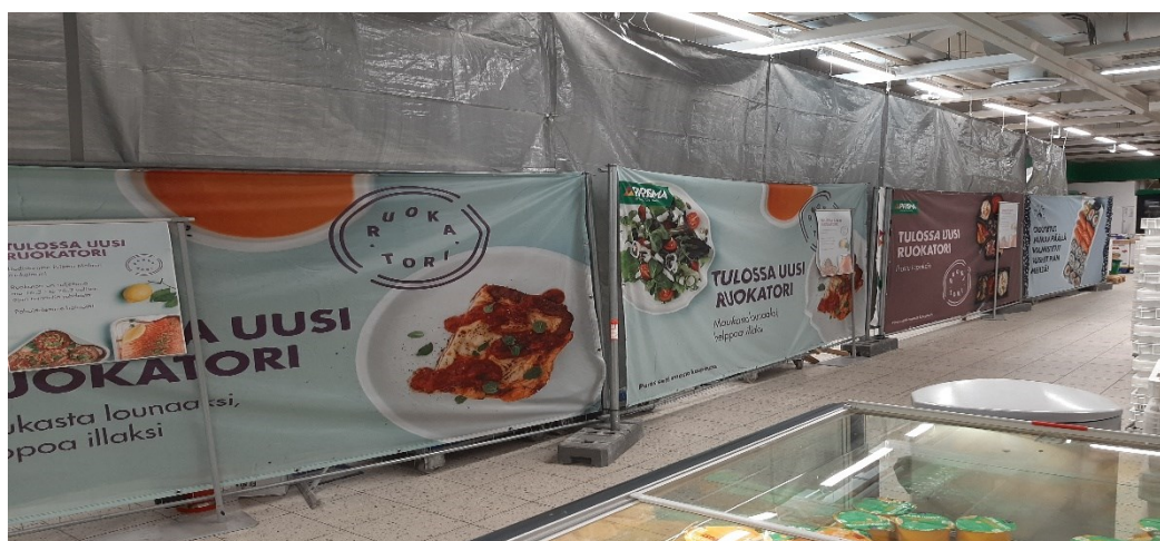
Kuva 3. Työmaan eristäminen aidalla Malmin Prisman työmaalta huhtikuussa 2020
