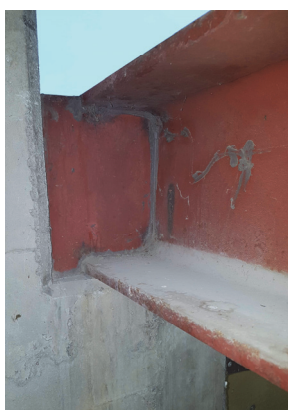
Figur 14. Infästning till betongpelare vid hallens gavlar.
