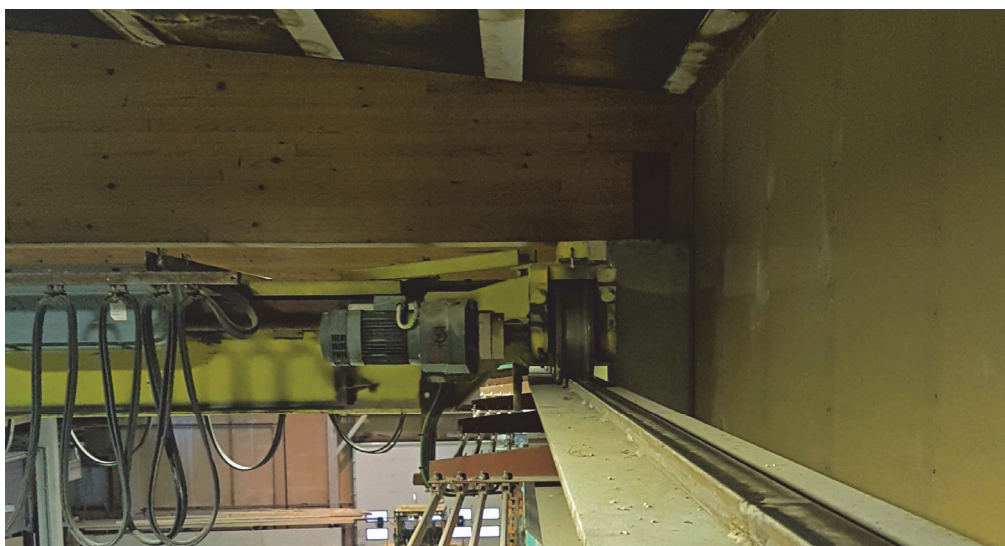
Figur 13. Intermittent svetsad platträl ovanpå kranbanans övre fläns.
