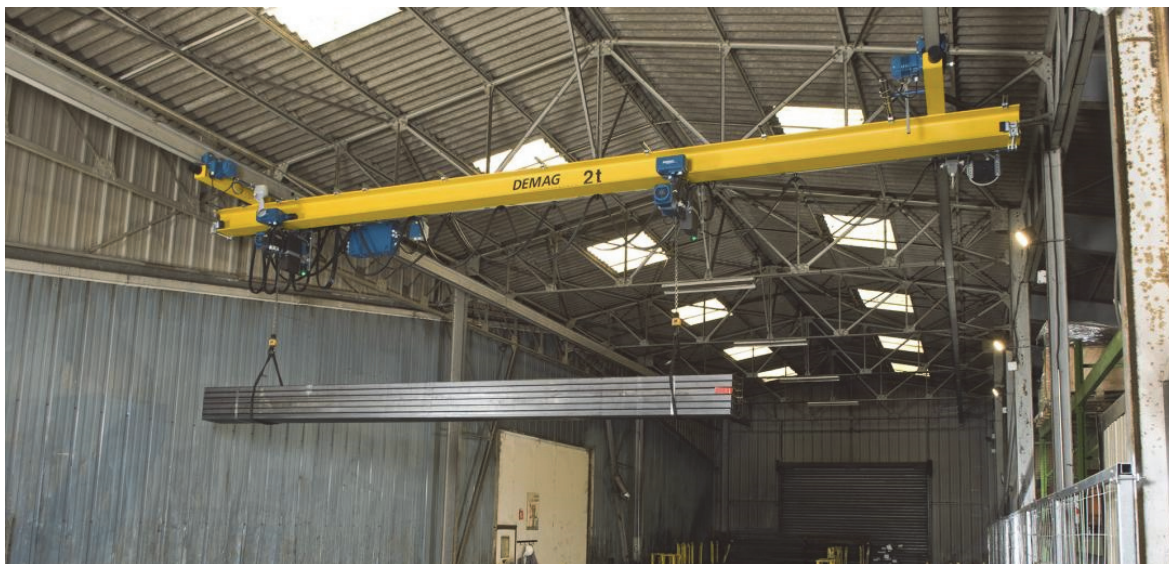
Figur 2 Hängtraverskran monterad till fackverken. [5]
