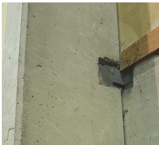
Figur 10. Övergången från sockelns betongelement till träspantervägg.
