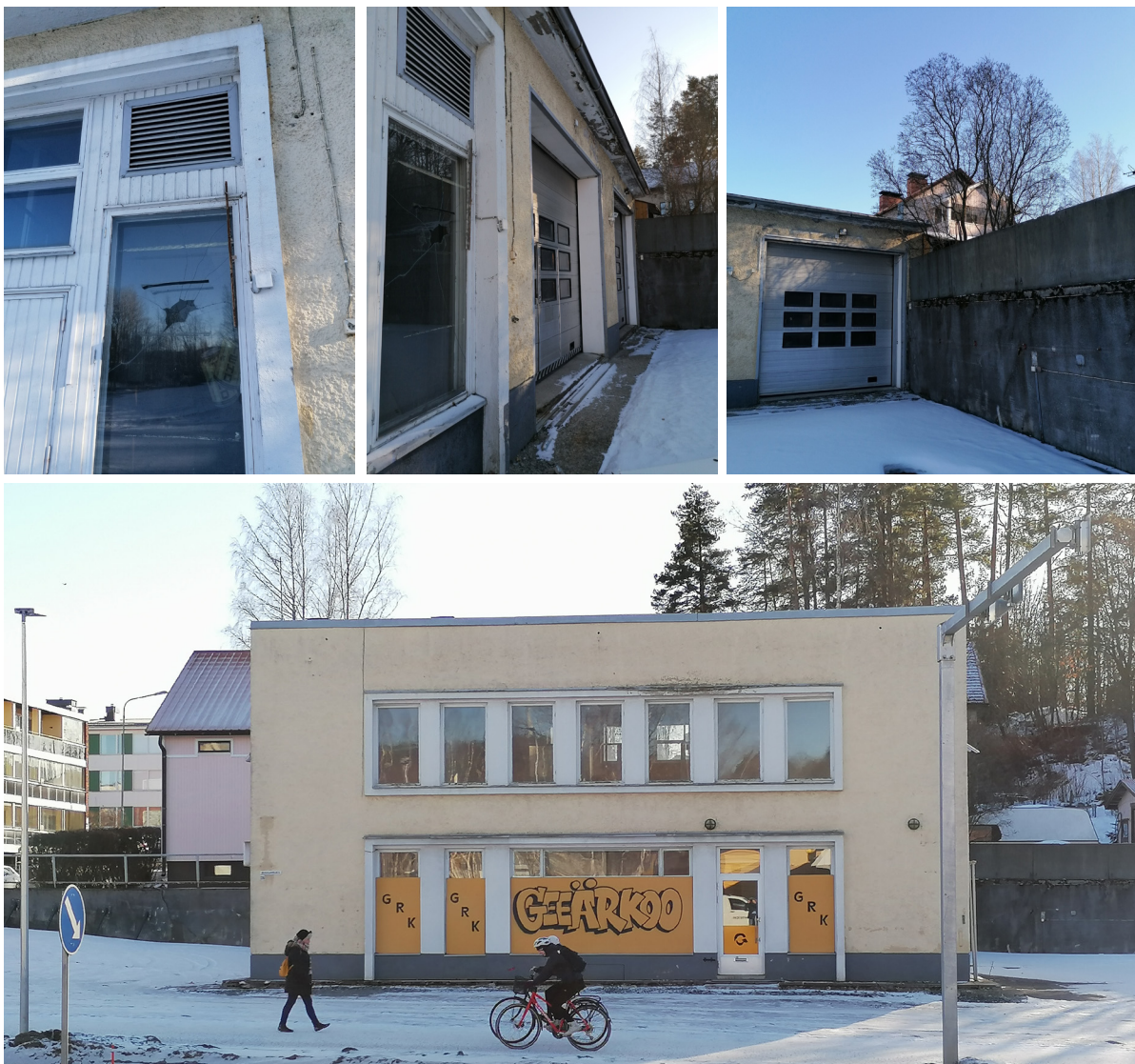
KUVAT 61 - 64. Kuvia rakennuksen julkisivuista (Pirainen 2020)
