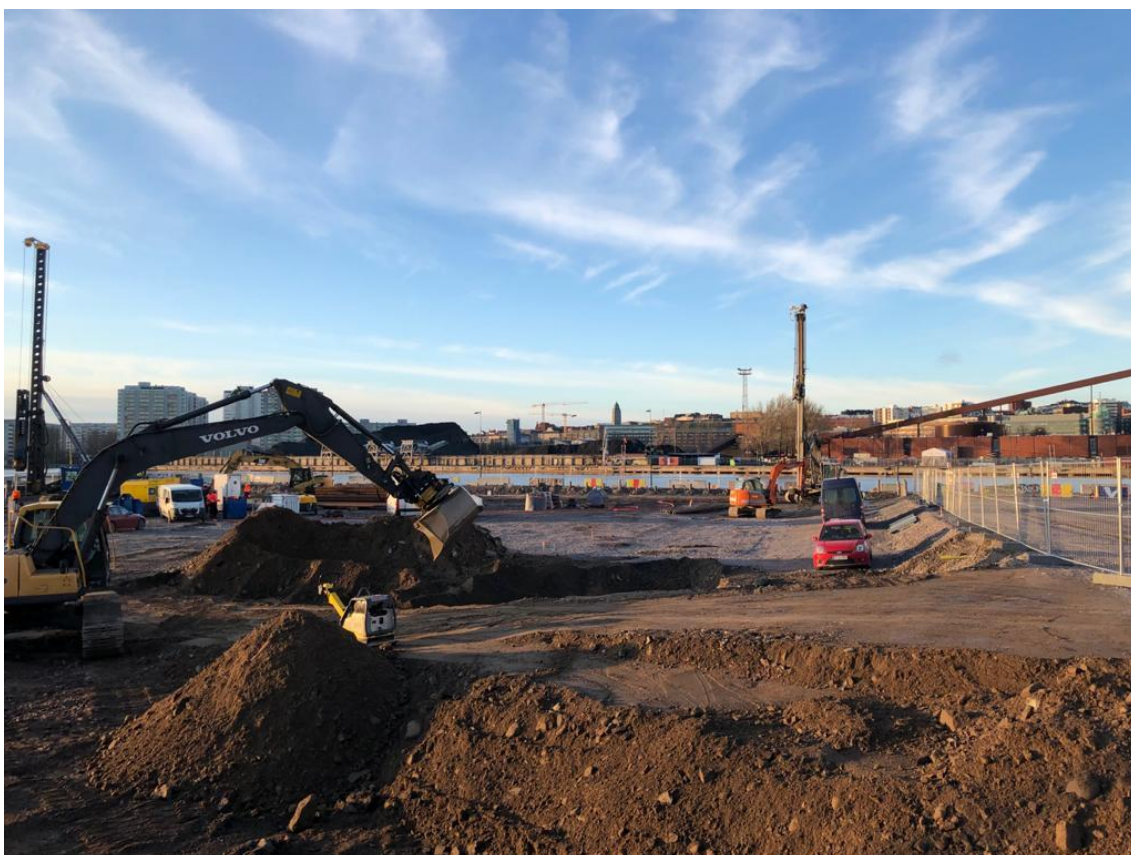
Kuva 17. Moreenin koostumusta työmaalla koneen etuosassa
