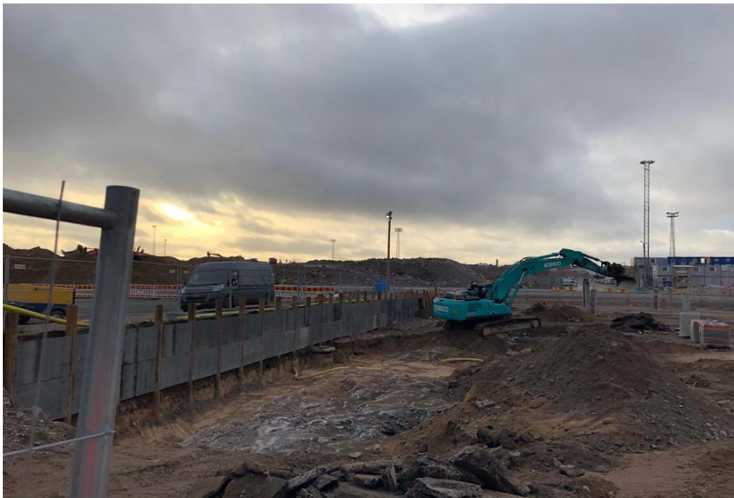
Kuva 14. Kobelco sk 350 kaivamassa maa-ainesta pois tulevien anturapohjien edestä.
