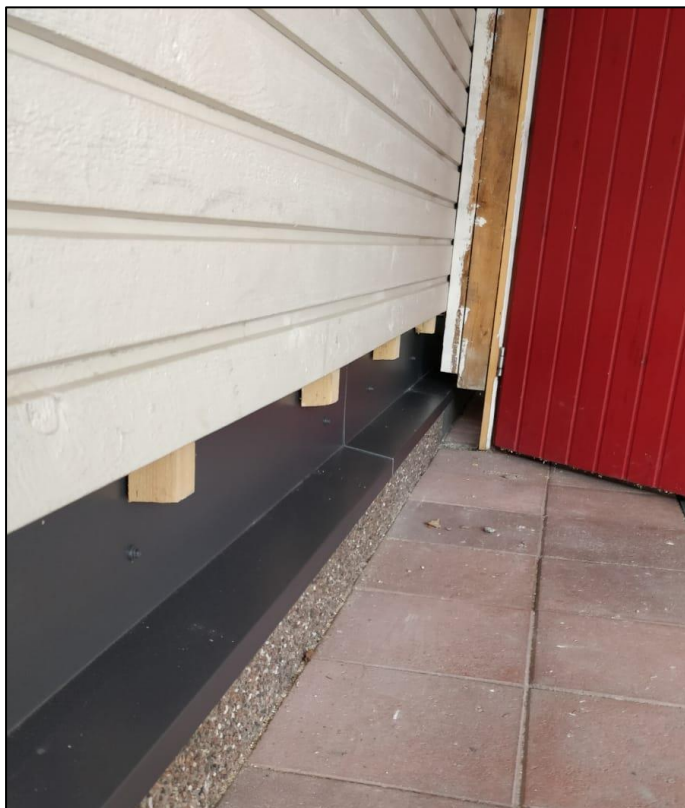
KUVA 12 Sokkelin suojapellytys (Heiskanen)
