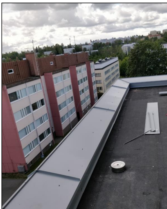
KUVA 4 Kermikaton räystäPELLI (Heiskanen)
