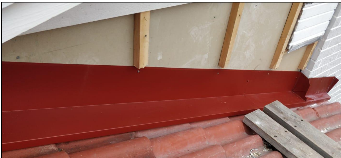
KUVA 7 Rintataitepelti tiilikatteella (Heiskanen)
