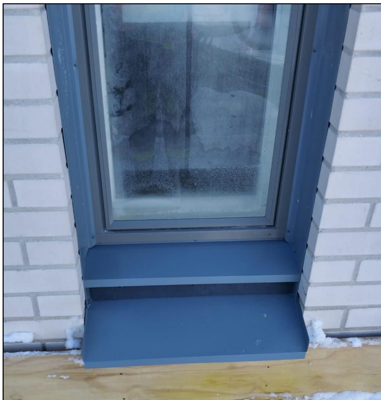
KUVA 10 Ikkunan vesipelti sekä ulkoseinäverhouksen suojaPELLIT (Heiskanen)
