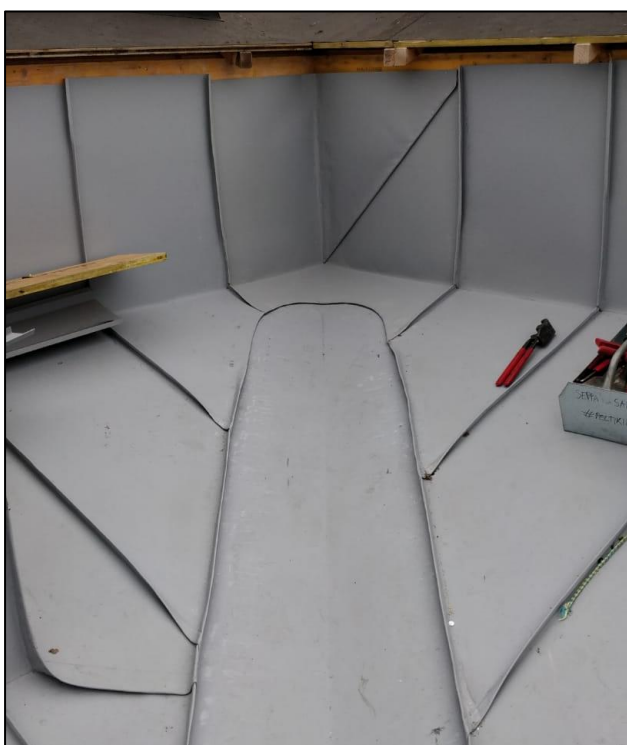
KUVA 8 Sisäjiiripelti ja rivien seinälle nosto konesaumakatteella (Kauhanen)
