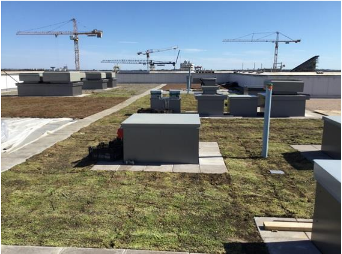
Kuva 3. Maksaruohomattojen koealuetta rakennetaan. (Kuva: Gazmend Dibrani)
