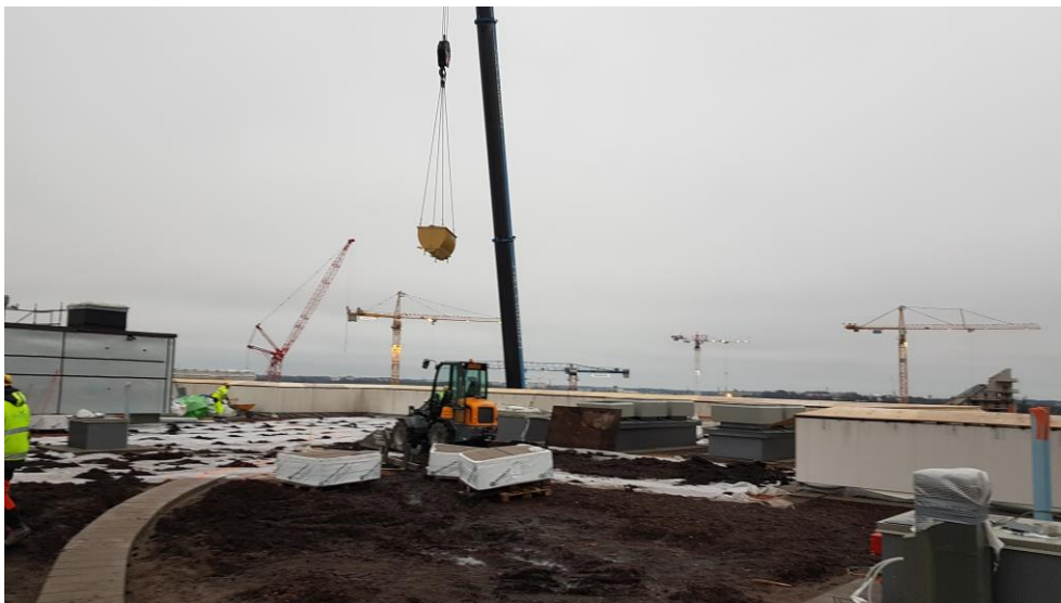
Kuva 4. Kasvualustaa nostetaan vesikatolle ajoneuvonosturilla. (Kuva: Gazmend Dibrani)
