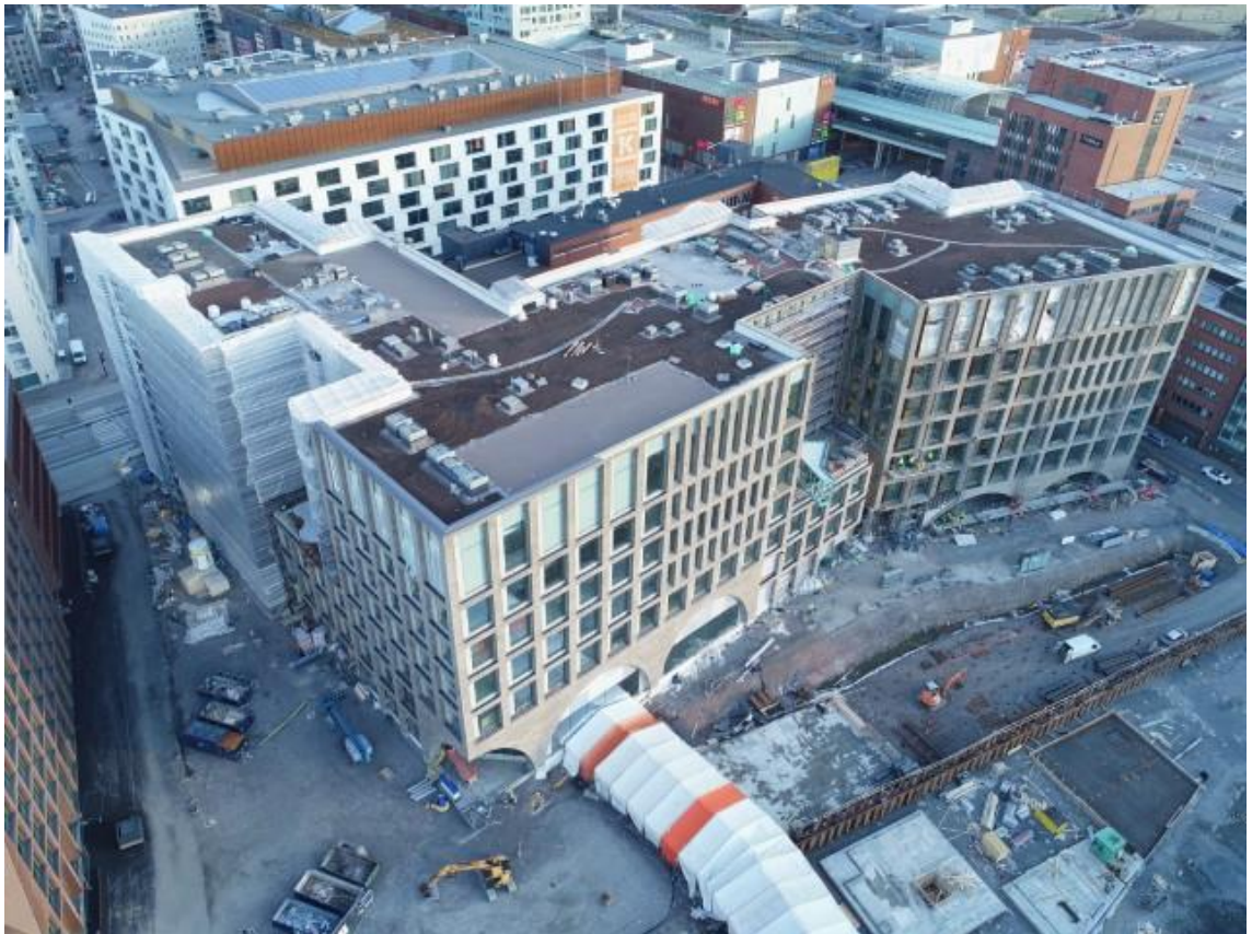
Kuva 6. Viherkattorakentamisen työkausi tammi-helmikuussa 2020. (Ilmakuva: Skanska Talonrakennus Oy)
