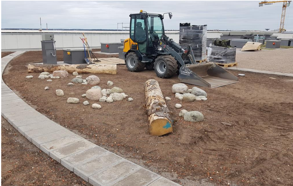
Kuva 5. Vesikatolla kasvualustaa siirrettiin pyöräkuormaajalla. (Kuva: Gazmend Dibrani)
