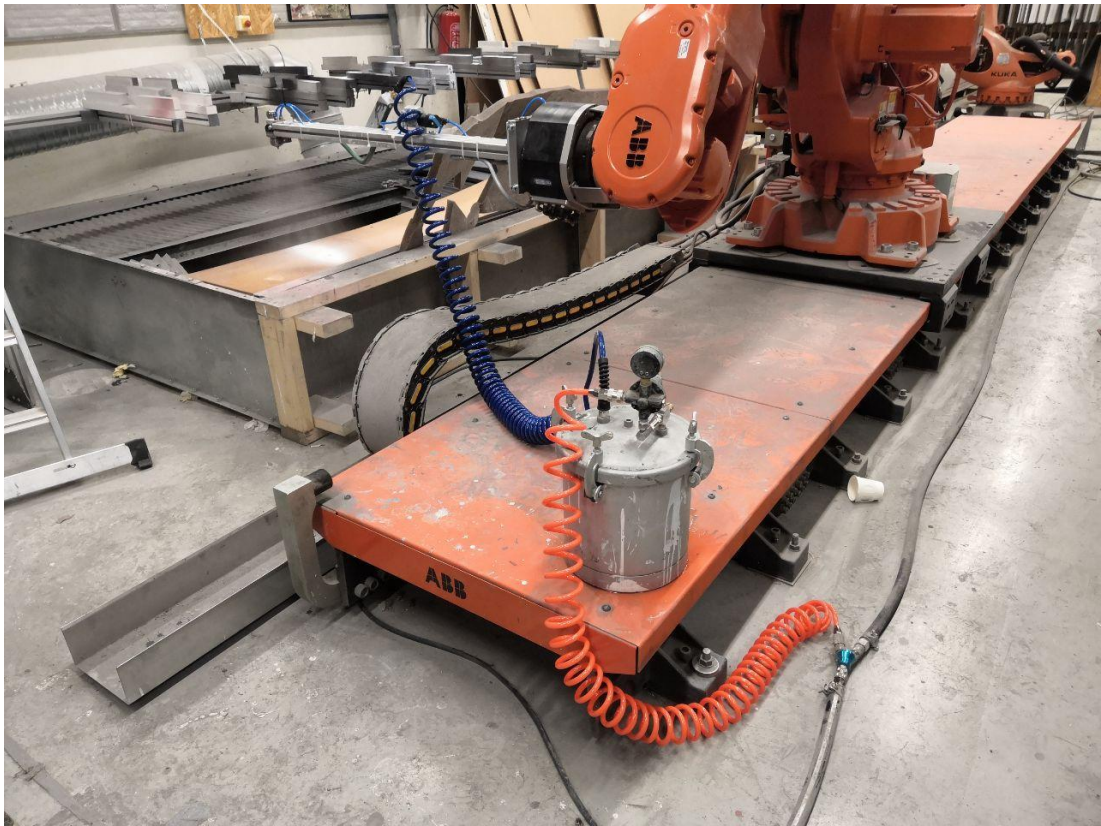
Kuva 19. Lopullinen maalausjärjestelmä, ennen paineistetun maalisäiliön sijoittamista oikealle paikalle.
