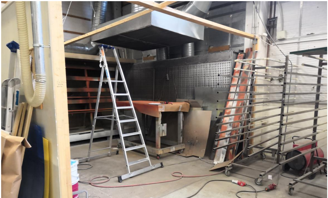
Kuva 2. Maalaamo ennen muutostöitä.
