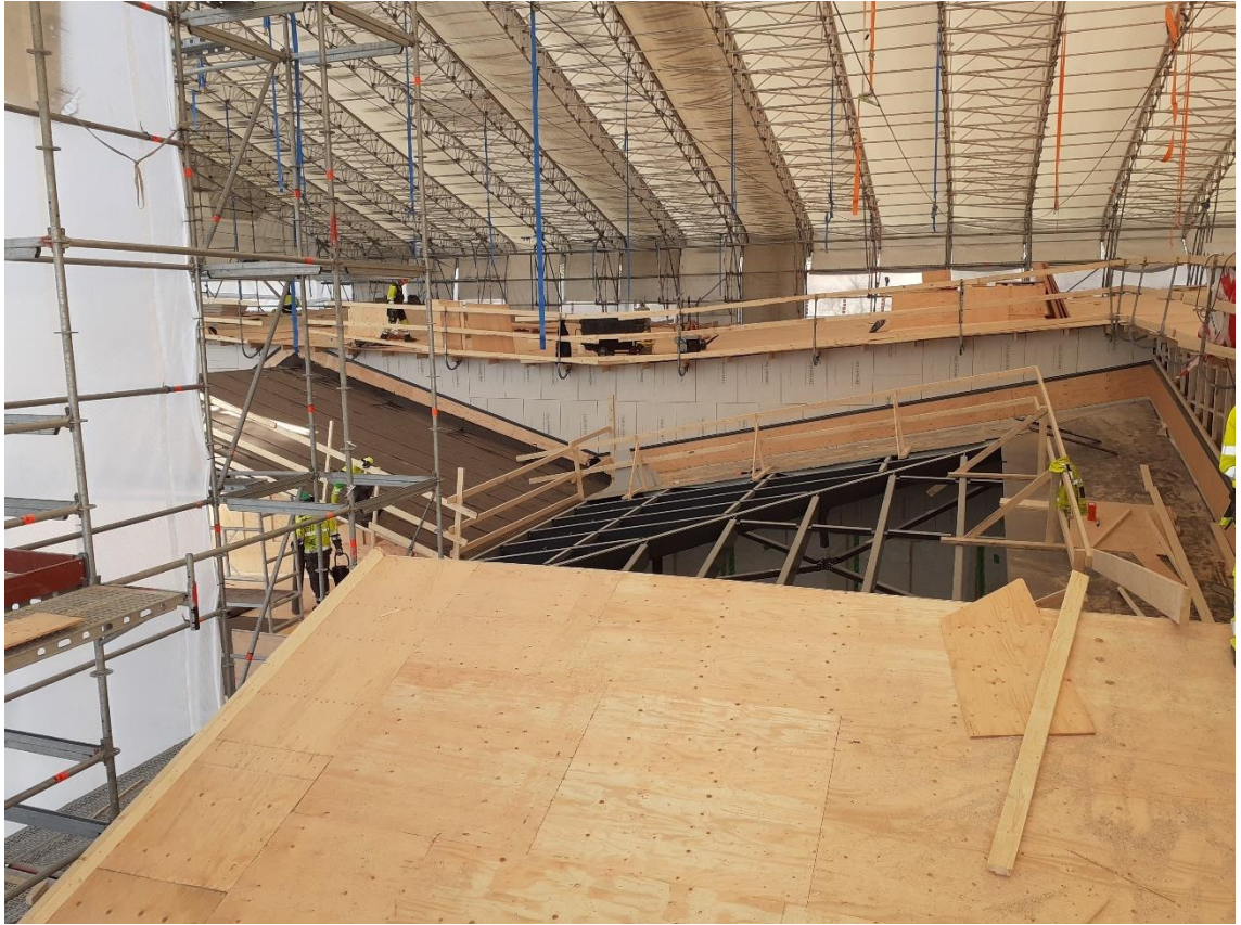
Kuva 3. Atrium vesikatolta (kuva Miia Virolainen 8.4.2020)
