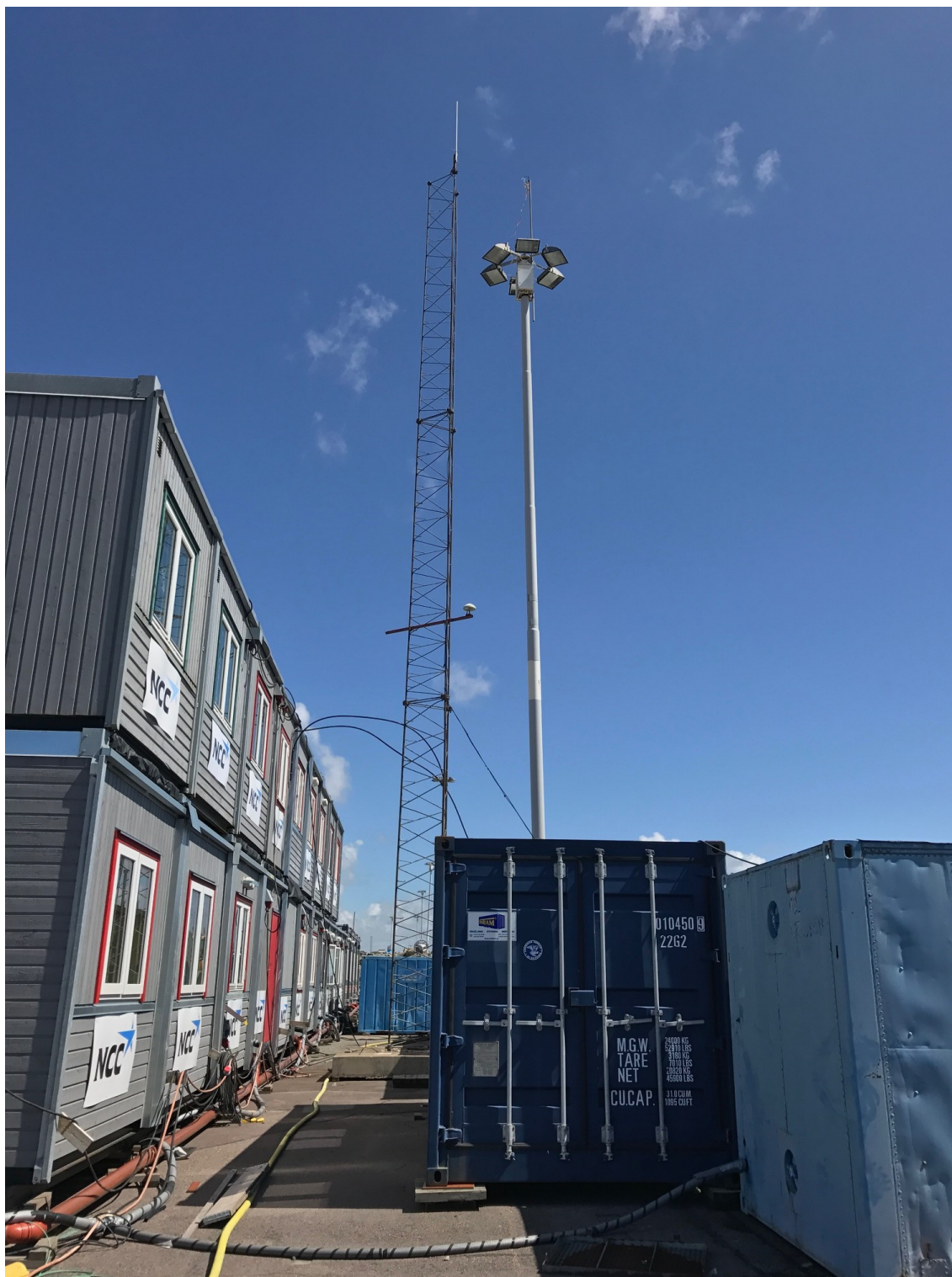
KUVA 9. Siirrettävä tukiasema merikontissa ja antenni
