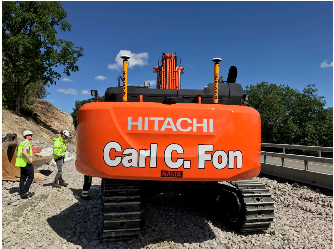
KUVA 5. Novatronin koneohjauksella varustettu kaivinkone
