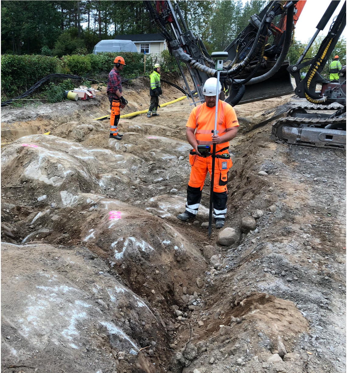
KUVA 2. Mittamies ottaa takymetrillä tarkkeen esiin kaivetusta kallion pinnasta
