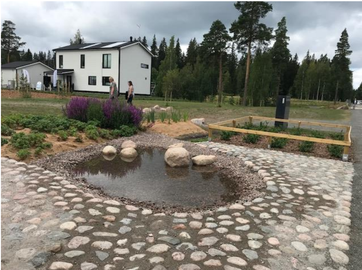
Kuva 7: Rakennettu hulevesiallas Kouvolan asuntomessualueella.
