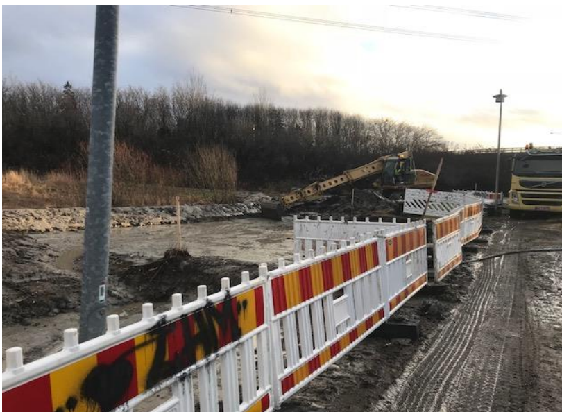
Kuva 11: Hulevesitietokeskuksen rakennustyöt ovat käynnissä.
