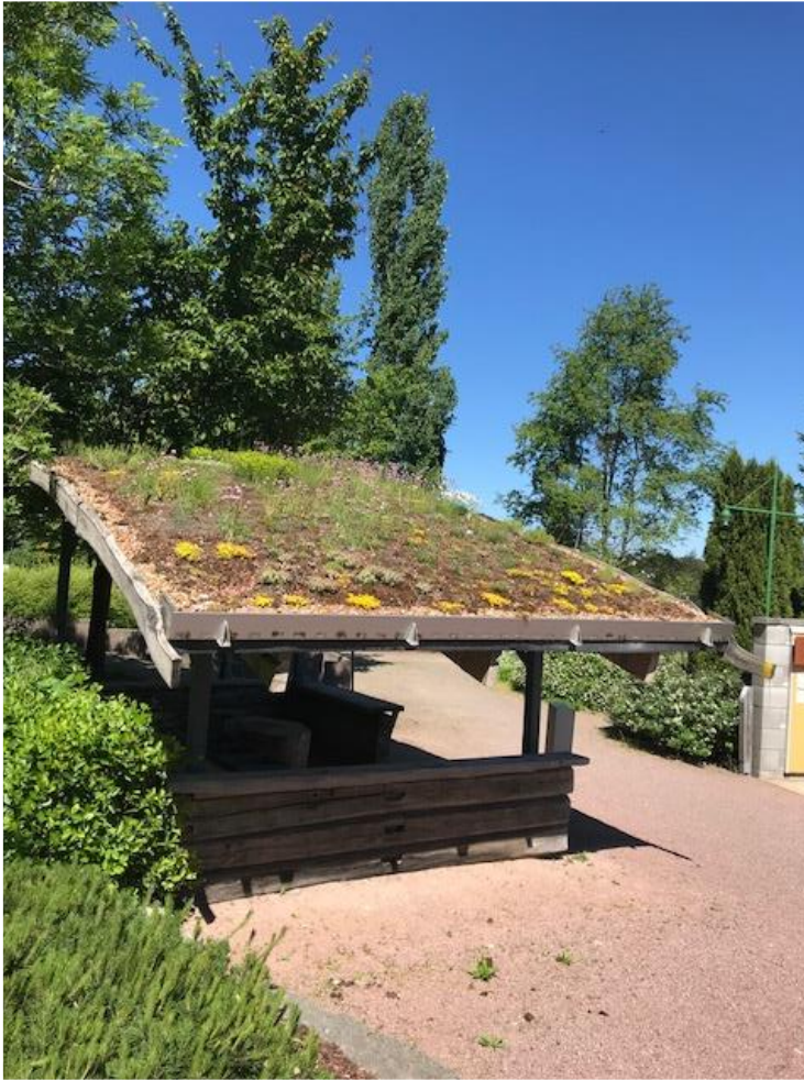
Kuva 3: Viherkatto ehkäisee hulevesien muodostumista kasvillisuuden imiessä vettä itseensä.
