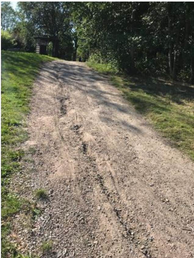
Kuva 14: Eroosio-ongelma uoman alkupäässä
