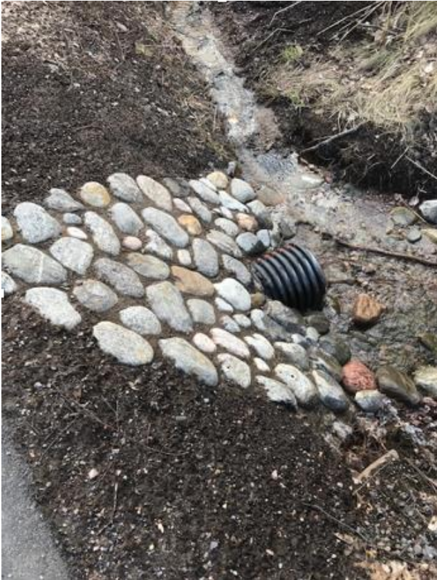
Kuva 15: Putken ulostulon suu voidaan verhoilla luonnonkivillä.
