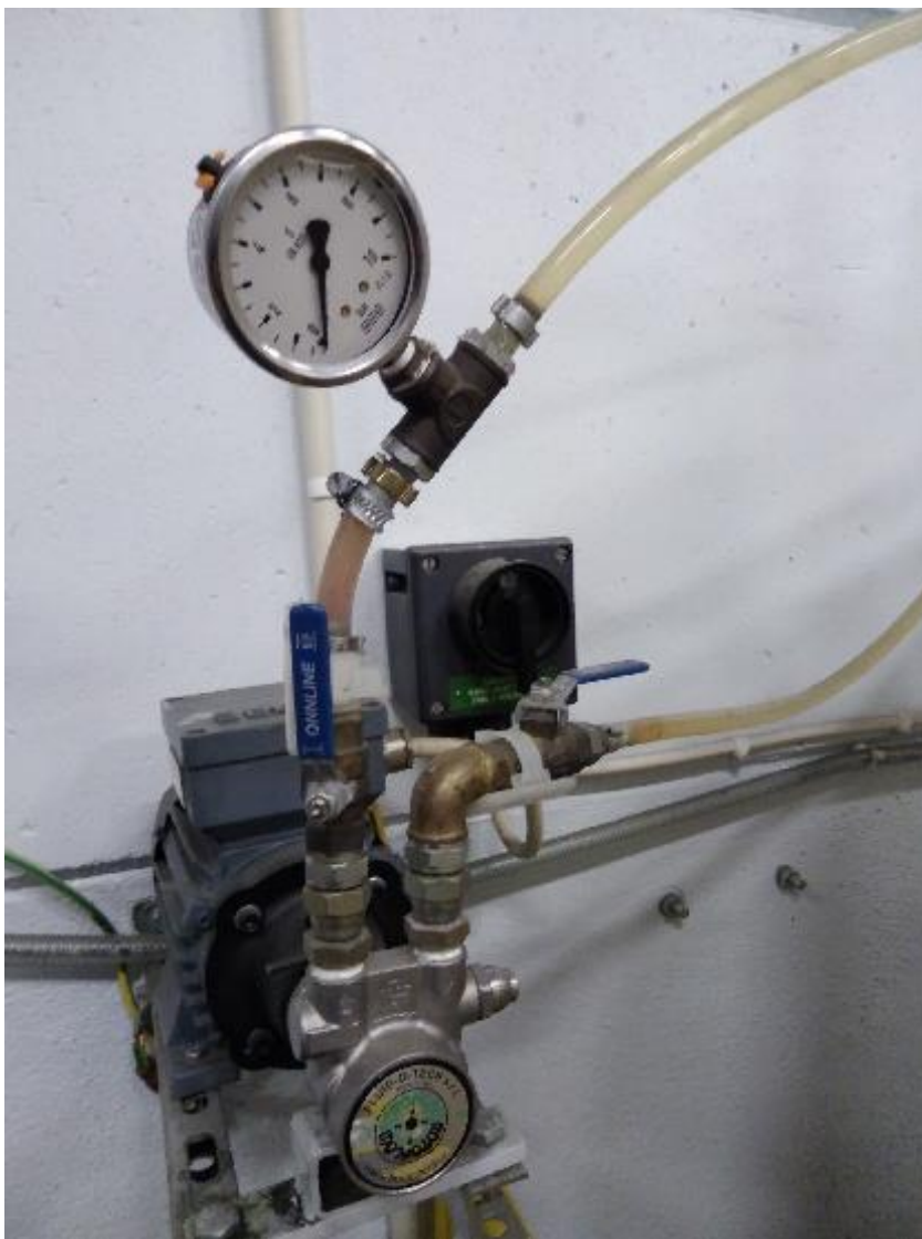
Kuva 5. Sähkötoiminen siipipumppu, joka pumpkaa valmiin seoksen linjalle.
