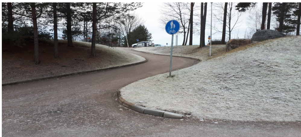
Kuva 16. Mäkkylä: Asemalta Leppävaaran puoleiselle autoparkille johdava luiska, pituuskaltevuus pahimmillaan n. 12,6% (Kuusijärvi 2020).
