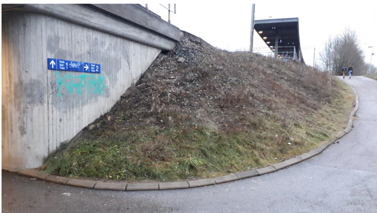
Kuva 11. Keran asema, 9,8 % pituuskaltevuus raide 2 :lle (Kuusijärvi 2019).
