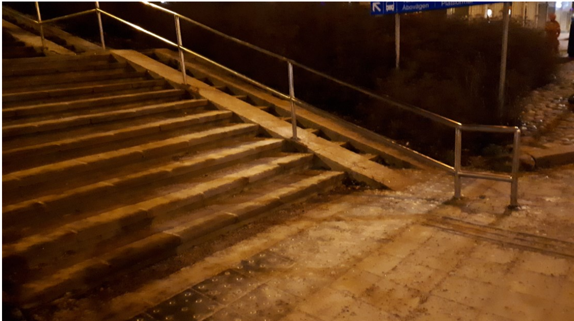
Kuva 26. Käsijohteet alimmillaan vain korkeudessa 64 cm ja 25 cm Turuntien bussipysäkille 33 ja 34 johtavissa portaissa
