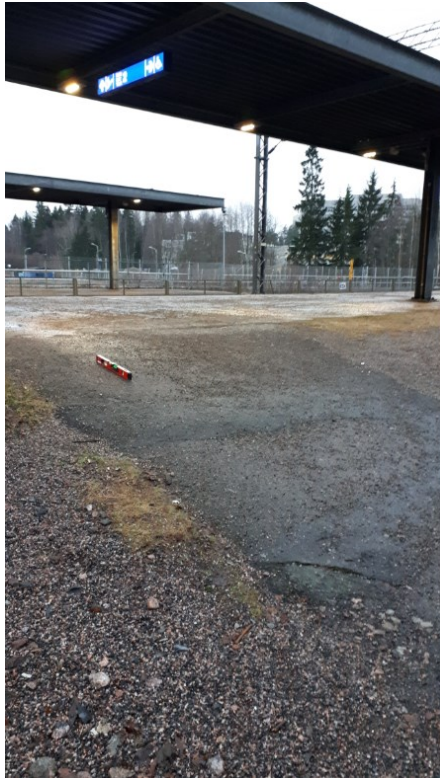
Kuva 12. Raiteelle 1 mentäessä pituuskaltevuus jopa 12,8 % (Kuusijärvi 2019).
