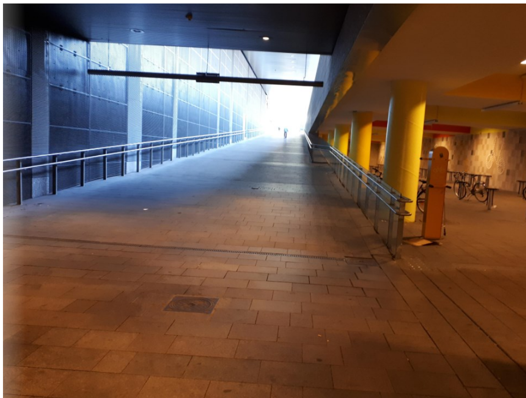
Kuva 24. Alepan kohdalta tunnelista bussiasemalle lähtevän luiskan kaltevuuskulma on keskimäärin 7,15 % (Kuusijärvi 2019).
