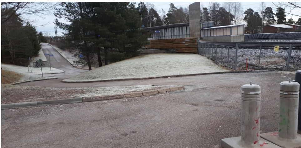
Kuva 17. Mäkkylä: Leppävaaran puoleiselta autoparkilta asemalle joh- tava luiska, pituuskaltevuus pahimmillaan n. 12,6% (Kuusijärvi 2020).
