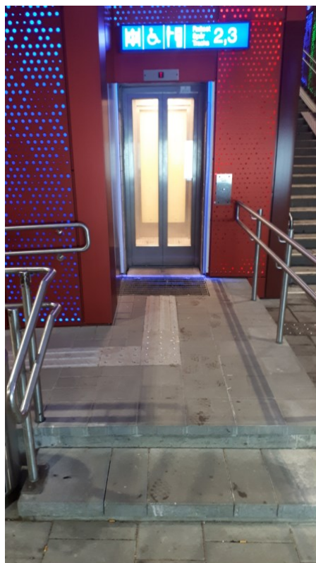
Kuva 31. Kirkkonummen aseman 80 cm leveä hissin oviaukko raiteille 2, 3 (Kuusijärvi 2020).
