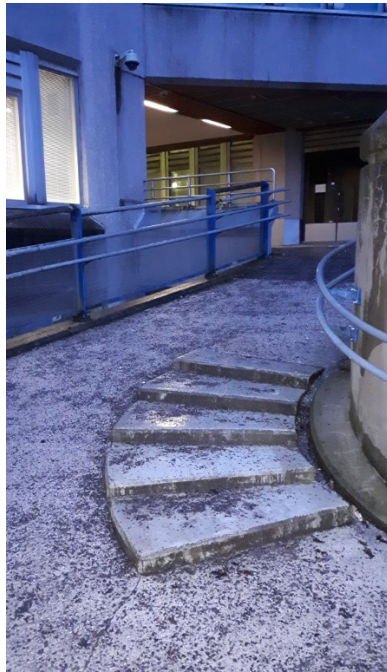
Kuva 5. Mitattu pituuskaltevuus n. 13% kuvan kohdassa Espoon asemalta Kirkkojärventien pohjoispuolella (Kuusijärvi 2020).
