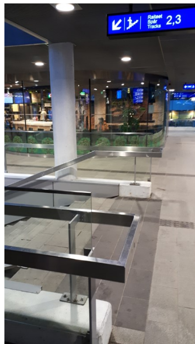
Kuva 4. Espoon keskuksen aseman sisällä vain yksi paksu käsijohde 96 cm korkeudella raiteille 2,3 (Kuusijärvi 2020).
