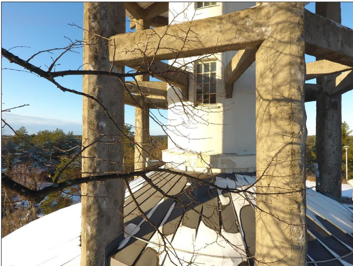
KUVA 10. Kuvassa näkyy kalkkihärmää, epätasainen valu ja verkkomaisia halkeamia
