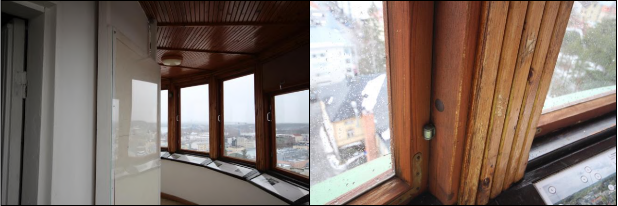
Ikkunoiden puitteet lahoiset ulko- ja sisäpuolelta, muutoin tasanteen kunto hyvä.
