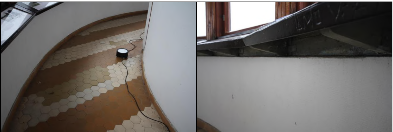
Valokuvatasojen alla on betonikaiteen päällinen laho alajuoksu ikkunakarmeille.
