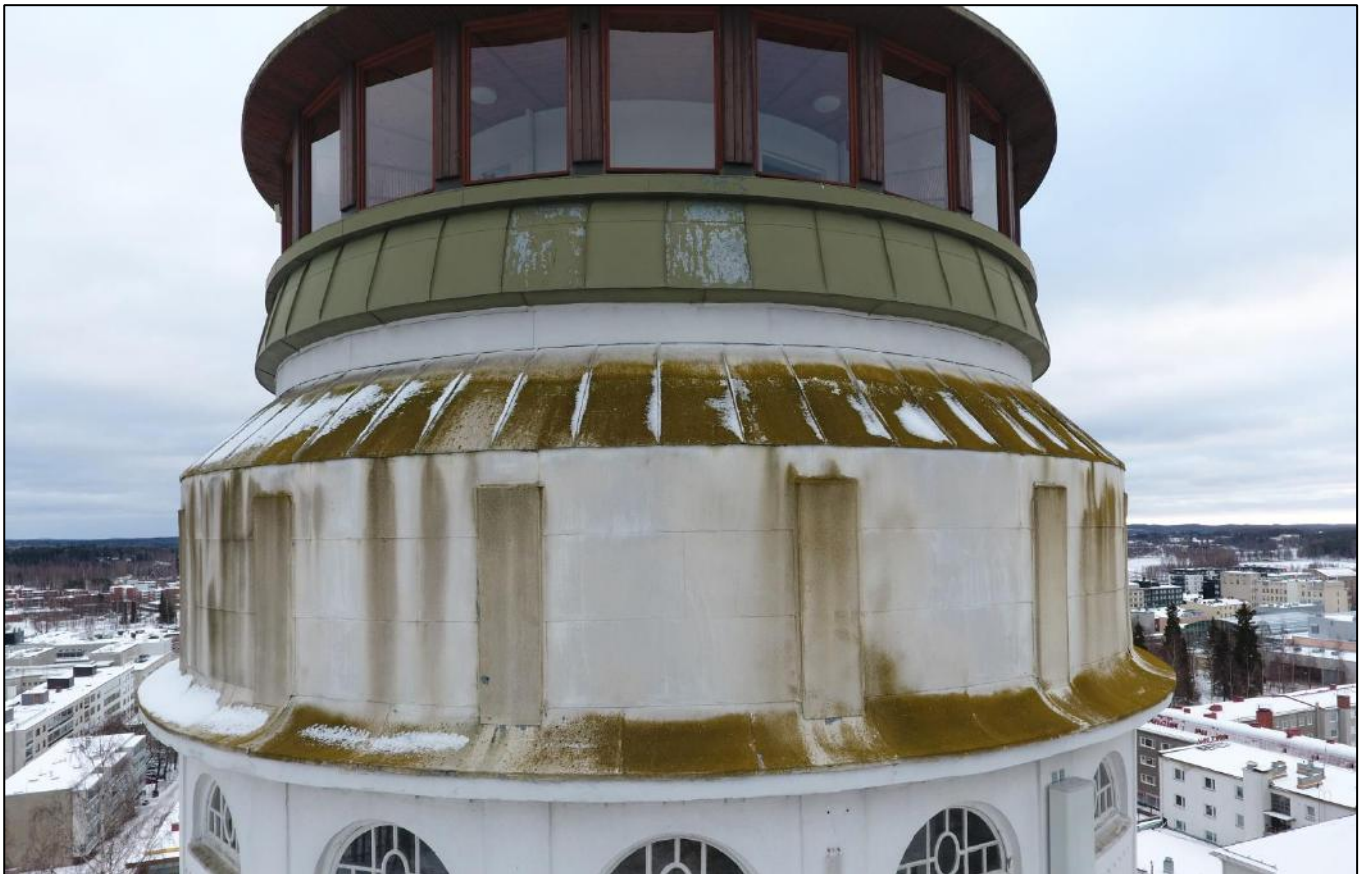
KUVA 6. Säiliön yläosien pellit likaiset, mutta ei ruosteen syövyttämät. Maalipinta vaikutti olevan verrattain paksu
