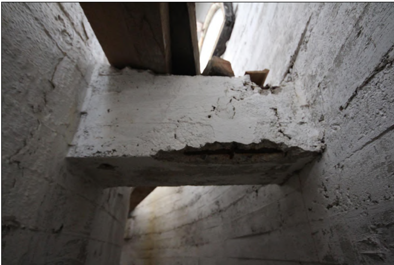
KUVA 5. Tukikonsolissa näkyy rapautumisvauriota, johtunee ruostuneen teräksen laajenemisesta vrt. routimiseen
