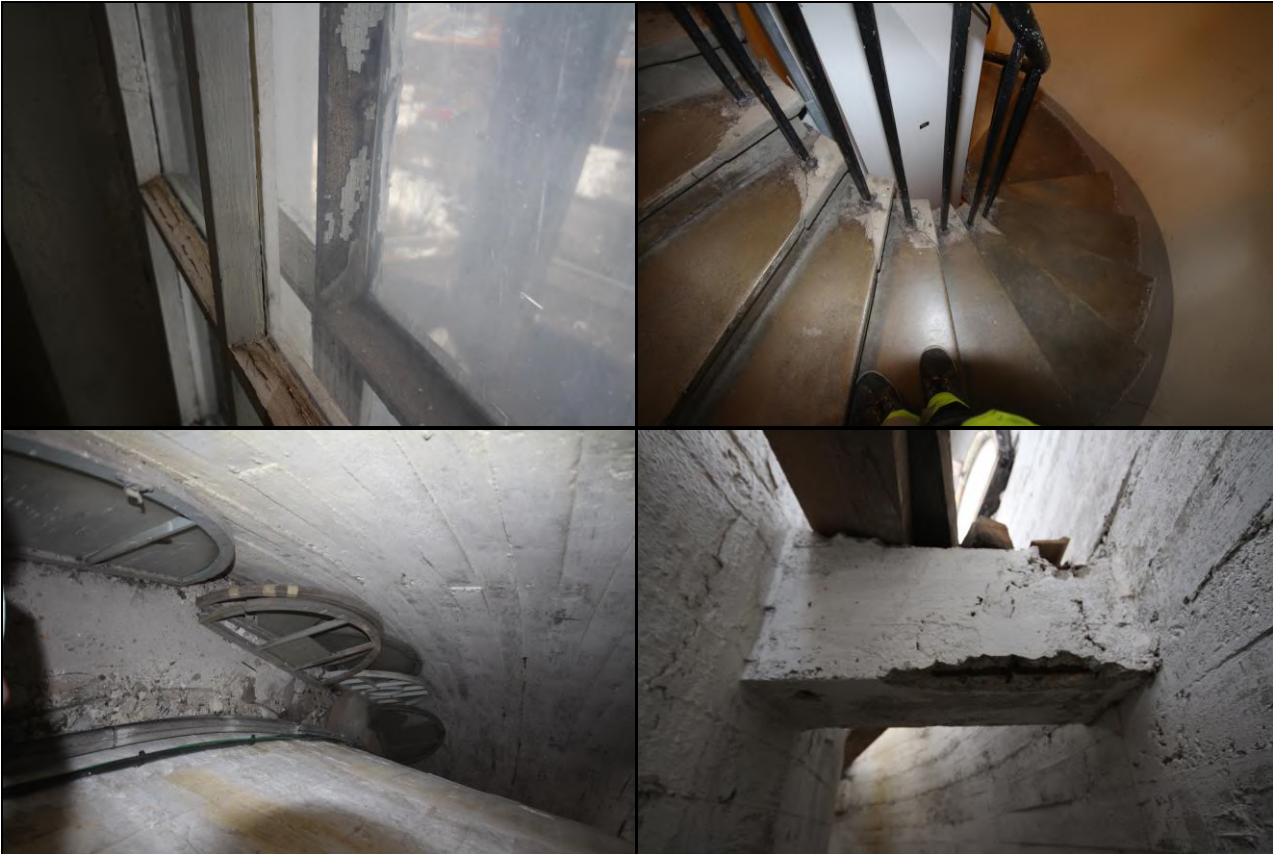
Kaksi ylintä kuvaa porrastornista ja sen pahoin vaurioituneesta ikkunasta, alemmat kaksi kuvaa huoltovälistä. Huoltovälissä säiliöiden välisissä tukipalkeissa eroosiovaurioita ja ikkunoiden varaosia.
