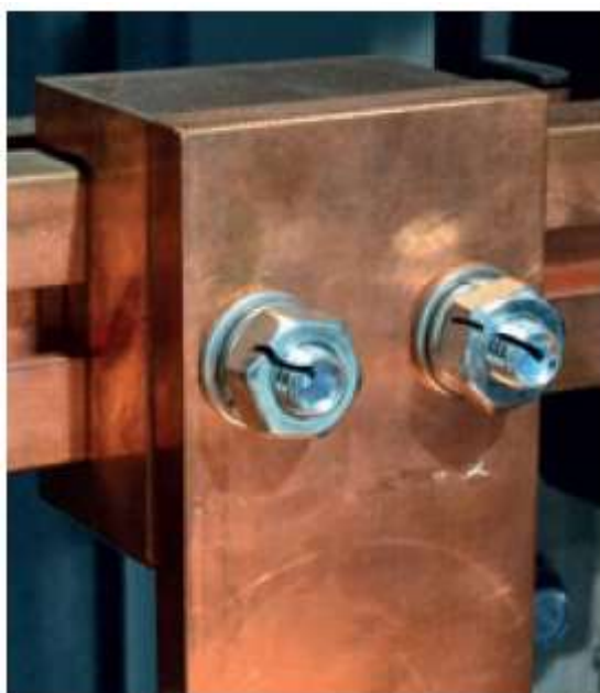
KUVA 34. Kupari - kupari kiskoliitos teräspulteilla. (Mäkinen & Koivisto, 2020)
