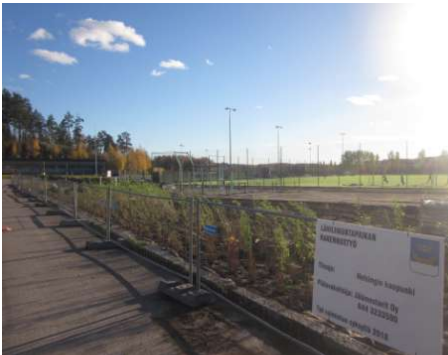
Kuva 13. Latokartanon uuden lähiliikuntapaikan rakennustyöt
