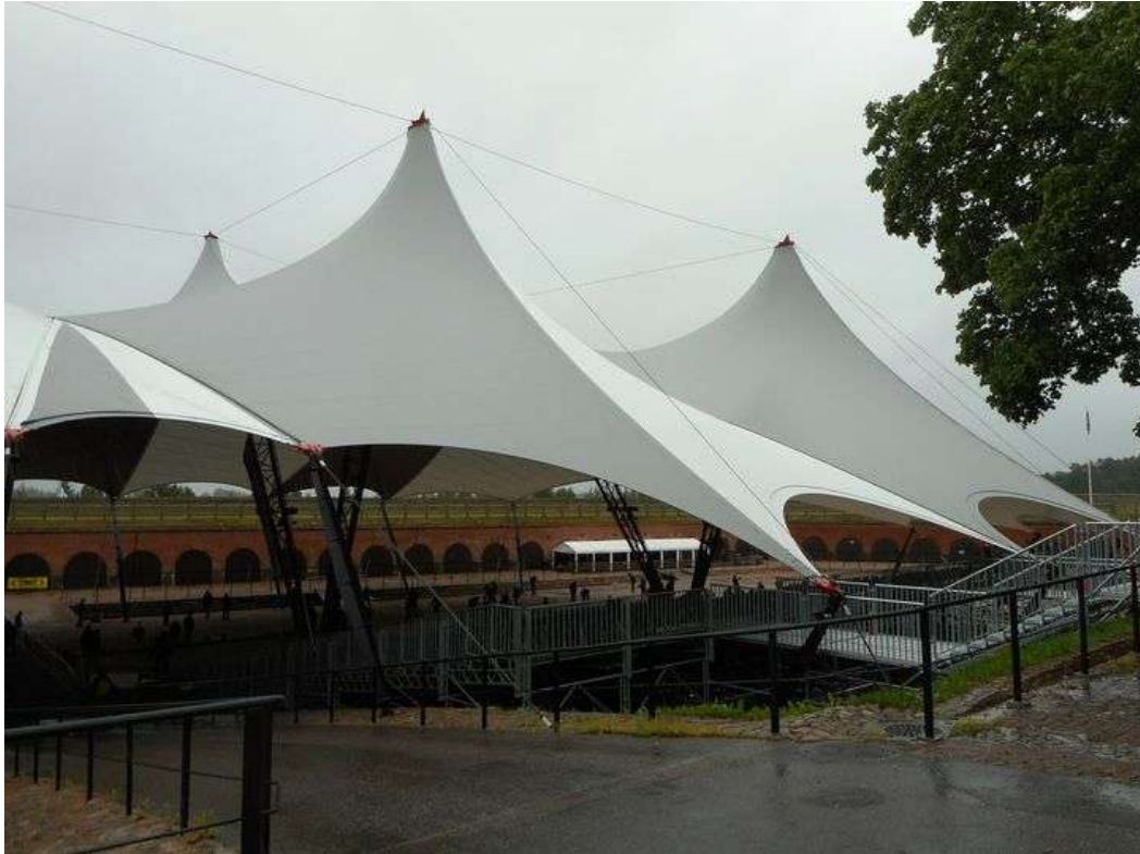
Kuva 49. 2016 petanquen SM-kisat Hamina Bastionissa pelattiin arkkitehtitoimisto Roy Mänttärin suunnittelemissa euroopan suurimmassa purettavassa telttakatoksessa.
