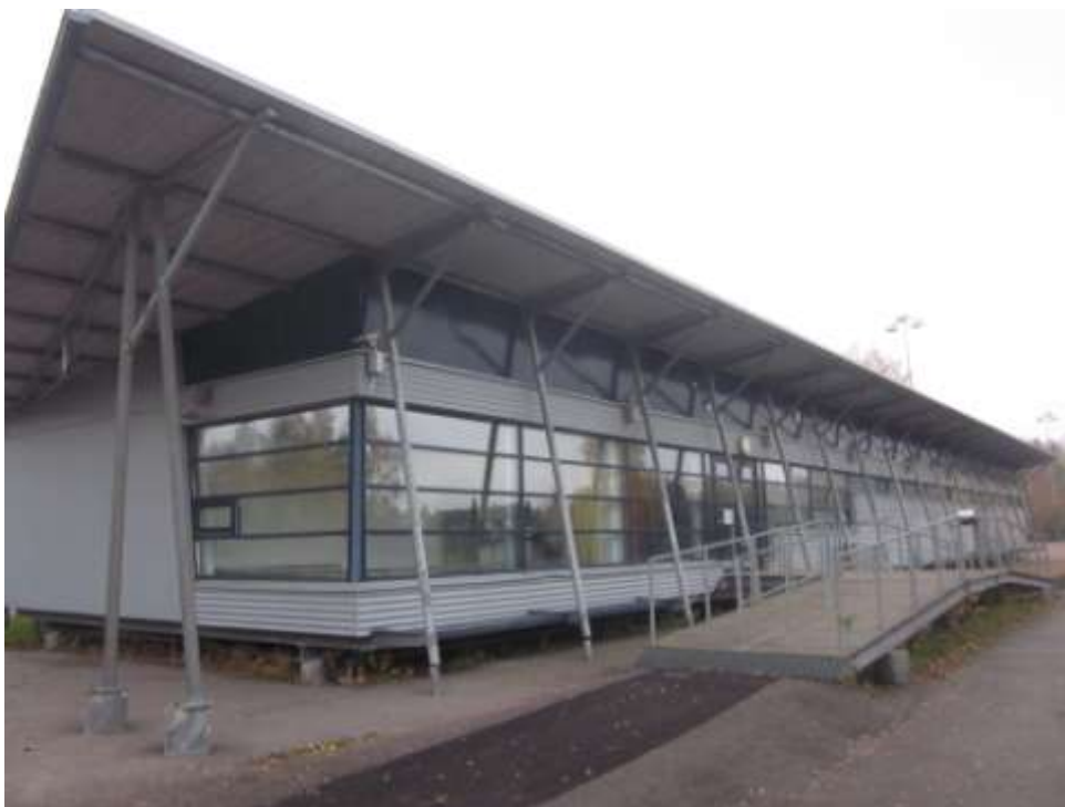
Kuva 32. Pukinmäen liikuntapuiston pukuhuone ja huoltorakennus
