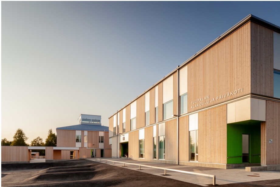
Kuva 8. Tuupalan alakoulu ja päiväkoti, Alt Architects, 2018. Ville-Pekka Ikola 2018.
