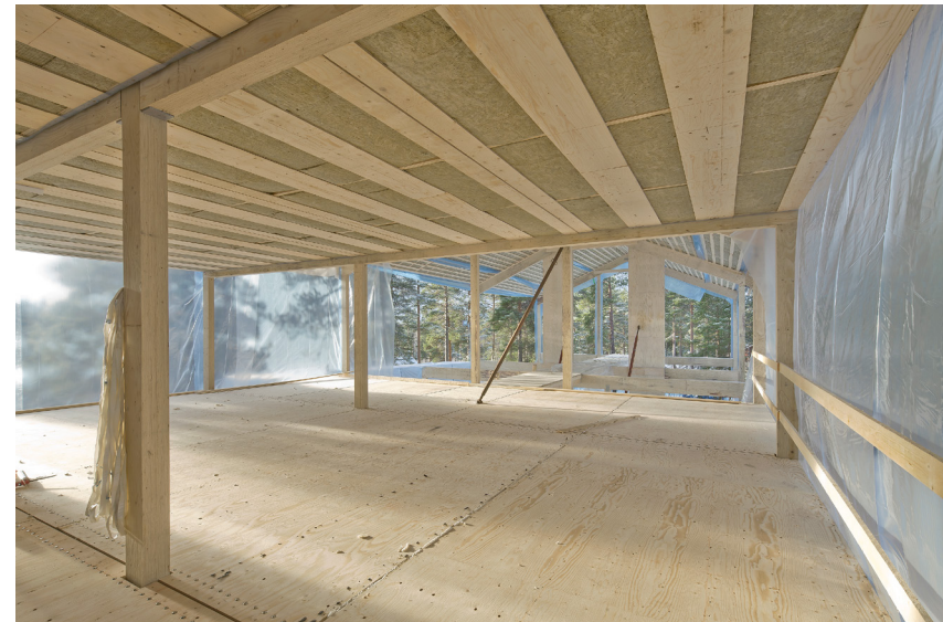
Kuva 10. Avoin, muuntojoustavutta tukeva rakennejärjestelmä. (Puuinfo)
