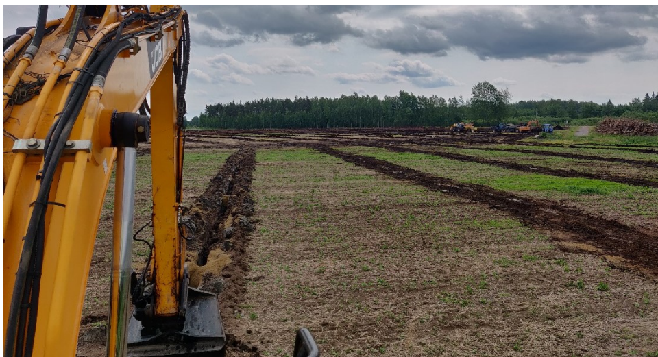
Kuva 9. Salaojien peittelyä tilan JCB Js130 -kaivinkoneella ja kallistuvalla luiskakauhalla Kukonkorvessa. (Mäkitalo 19.6.2019)
