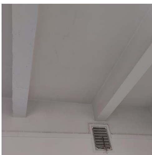
Figur 3 Mellanbjälklag av TT-plattor.
