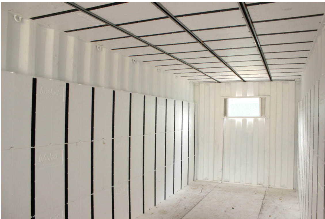
Kuva 13. Konttien sisäpuolinen eristys EPS:lla [12]
