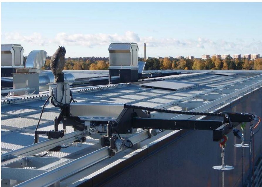
Kuva 3. Sähköisesti säädettävä Roca-kattovaunu [3.]
