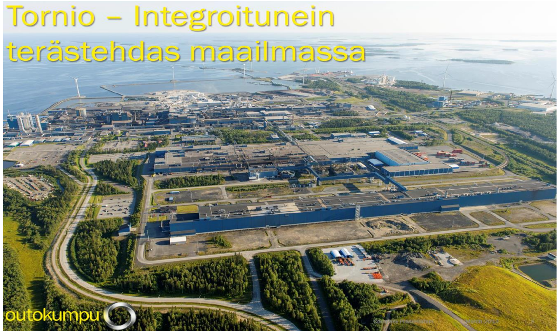
Kuva 2. Etualalla yli 700 metriä pitkä RAP5 halli (Outokumpu 2020c)
