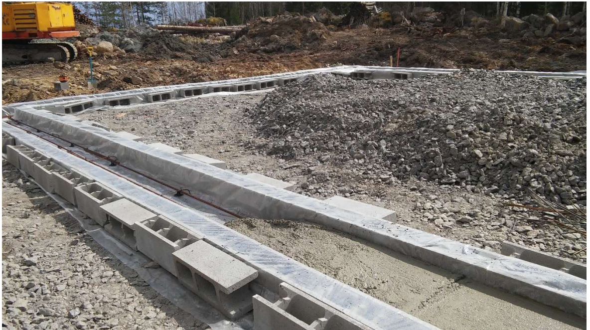
Kuva 3. Valuharkoista voidaan myös muodostaa matala anturamuotti ilman lisäkustannuksia.
