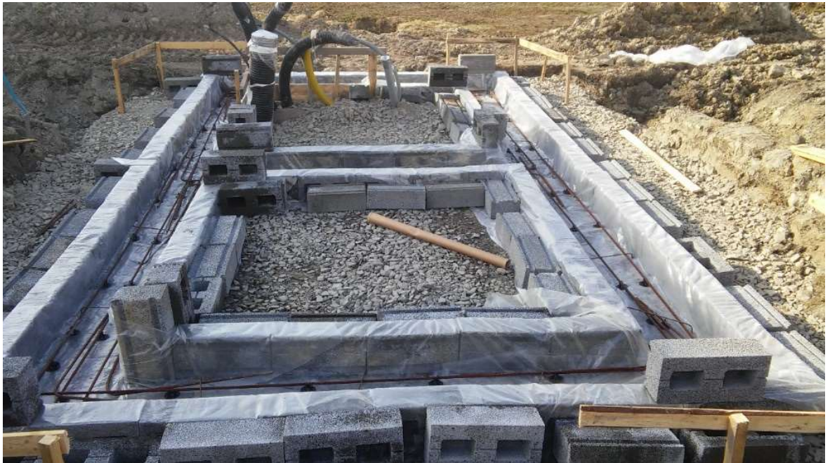
Kuva 4. Leca-harkoista koottu anturamuotti.
