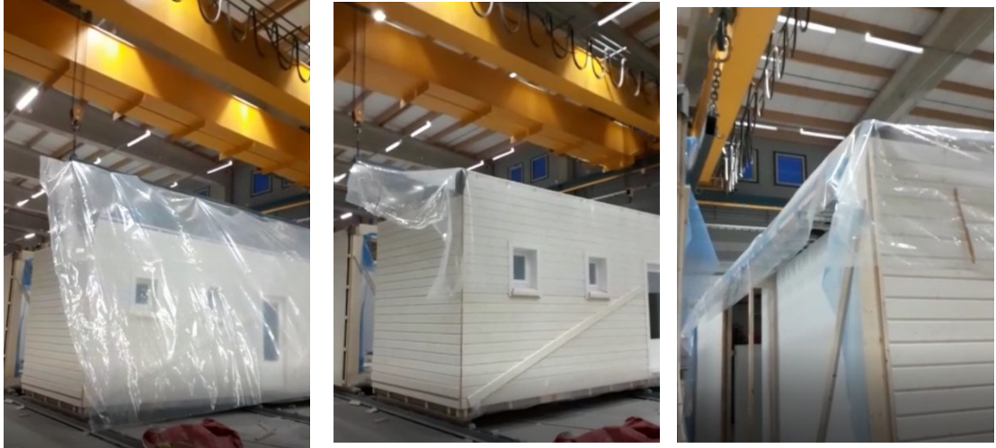
Kuvio 14. Kirkasmuovin asennus moduulin päälle. (Kuvat: Tornion talotehdas, Muura- metallot Oy)
