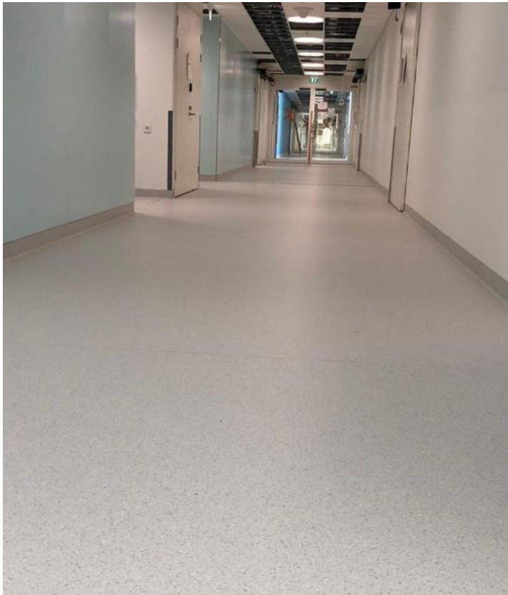
Kuvio 4. Muovimatolla päällystetty käytävä
