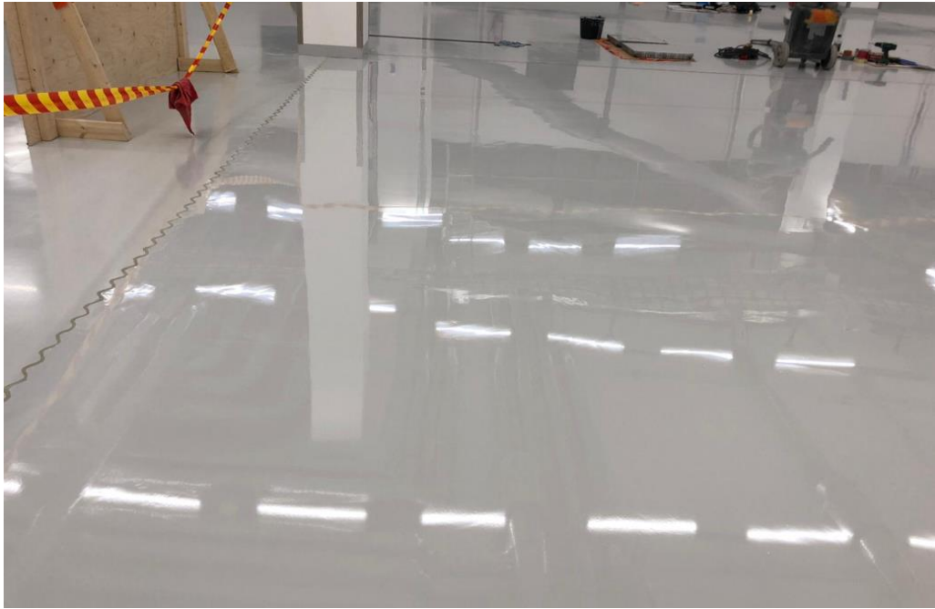
Kuvio 1. Epoksinnoite ennen lattian suojausta
