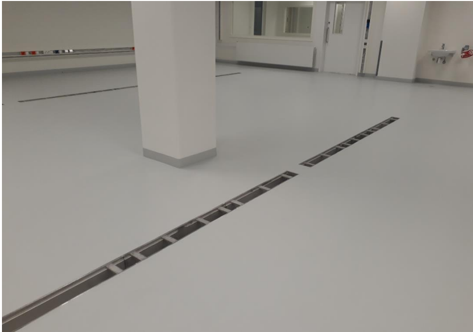
Kuvio 2. Polyuretaanipinnoite ennen lattian suojausta
