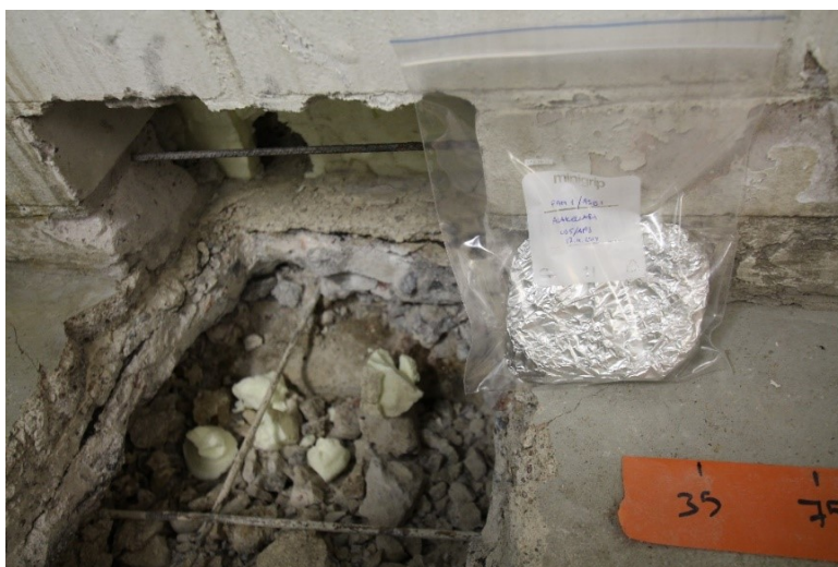
Kuva 7. Rakenneavaus ja materiaalinäytteenotto kuntotutkimuksen yhteydessä (Puranen, 2014)
