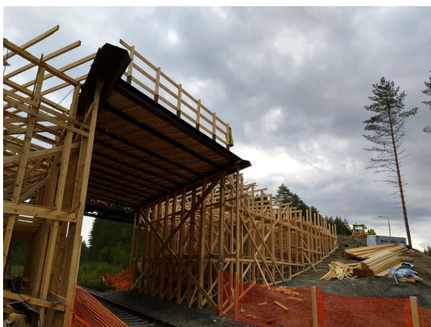
Kuva 12. Viinijärven ylikulkusilta rakennusvaiheessa. (Piisilä 2019)
