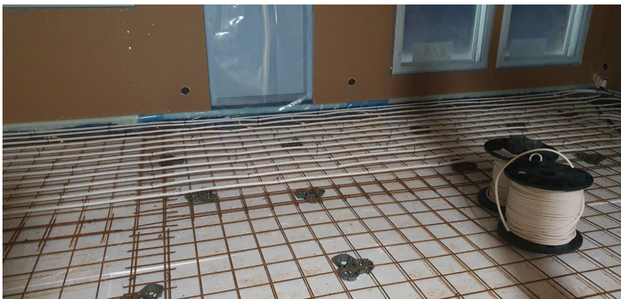
KUVA 7. Lattioiden raudoitus valmiina (Repo 2019-07-12)
