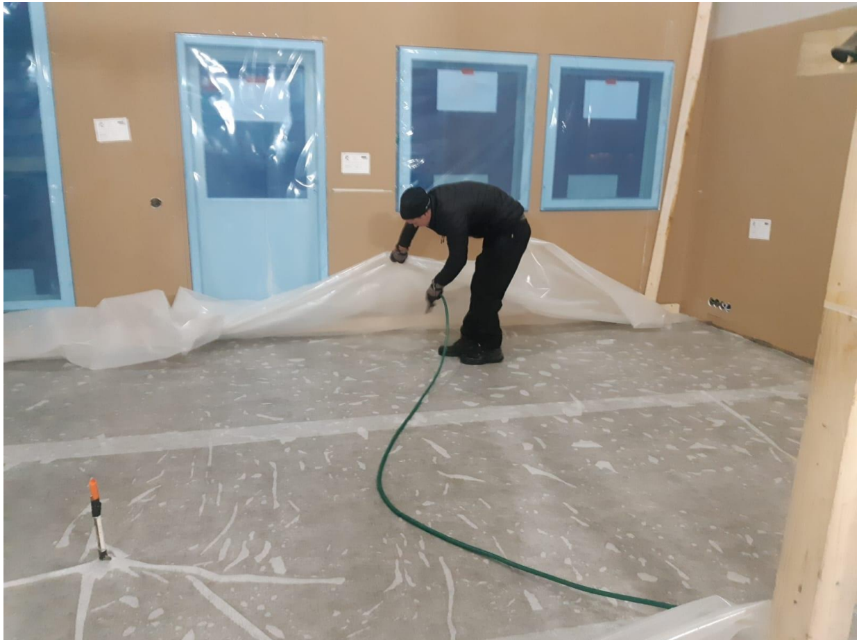
KUVA 9. Lattioiden jälkihoito (Repo 2019-25-12)
