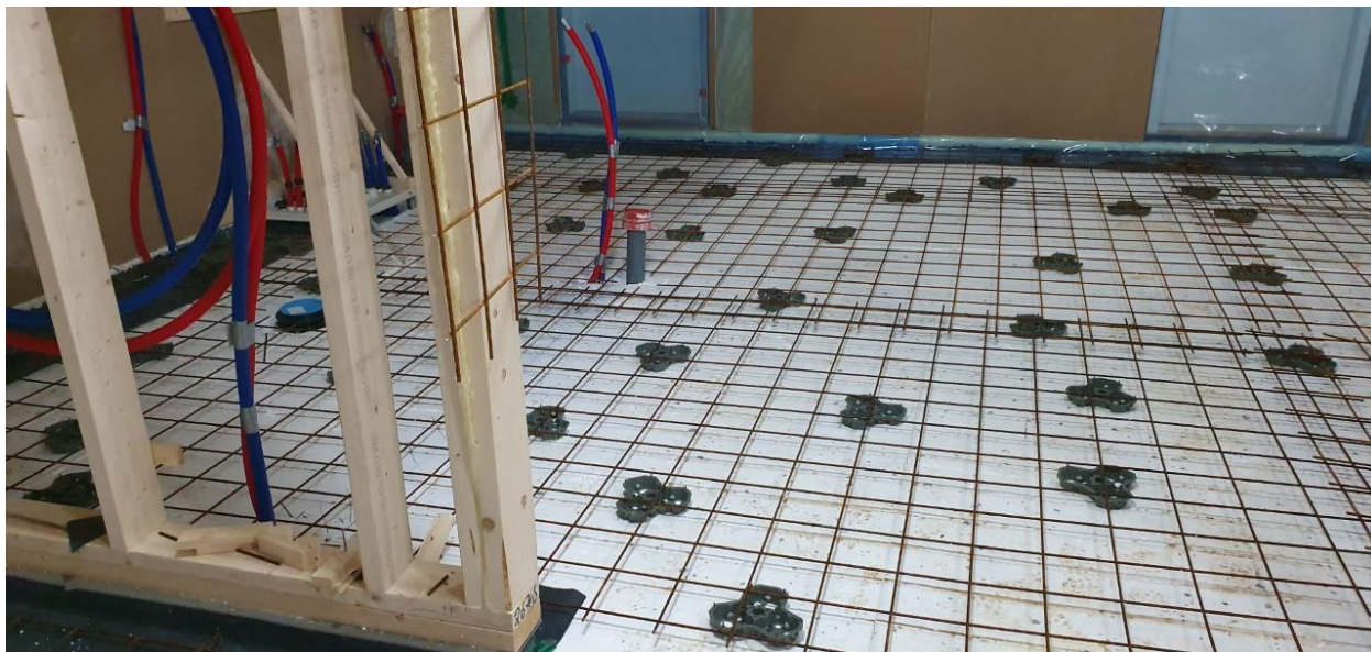
KUVA 6. Lattioiden raudoitus (Repo 2019-07-12)
