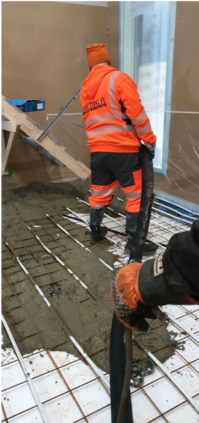
KUVA 8. Lattioiden valaminen (Repo 2019-22-12)
