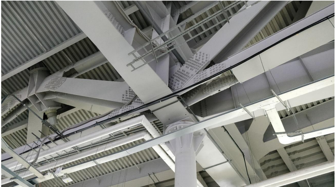
Kuva 5. Pietarissa olevan Gazprom Arenan teräsrakenneliitos
