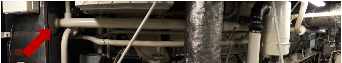
Kuva 7. Uusi viemäriputkilinja dieselkonehuoneessa ja linjan läpivienti polttoöljysäiliön kautta muonavarastoon.
