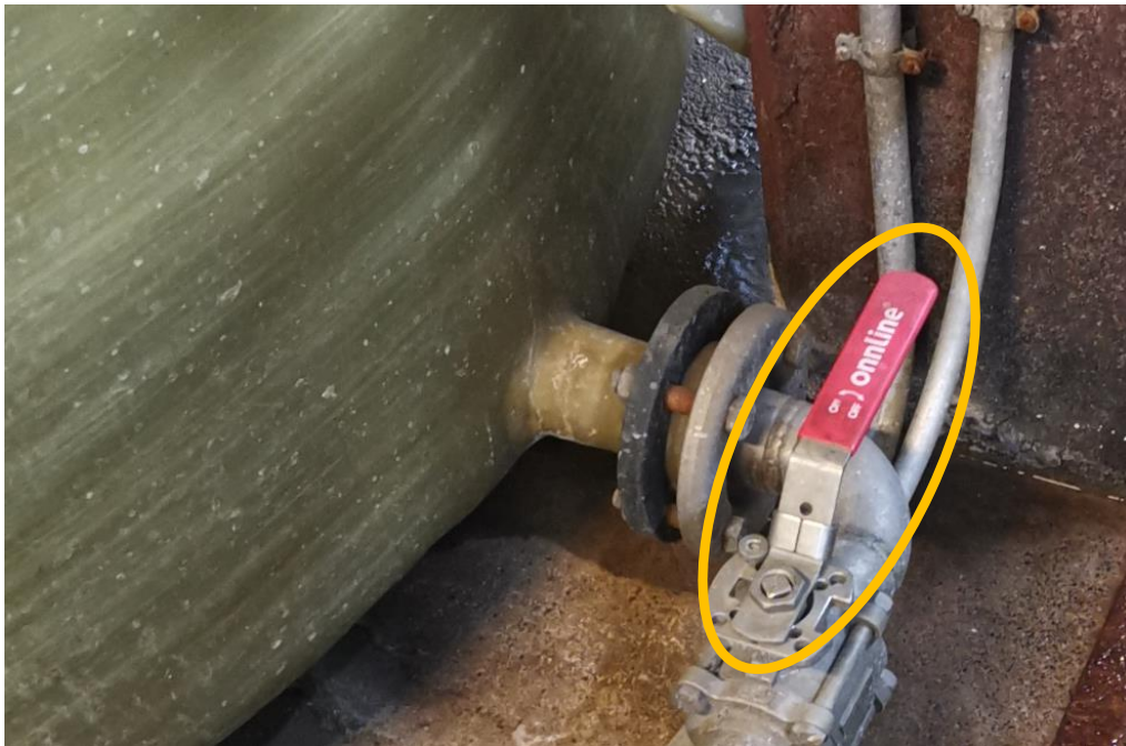
KUVA 2. Säiliön S-102 pohjaventtiili V-105
