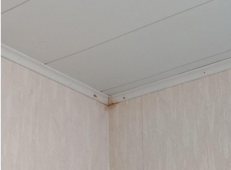
Bild 14. Ett ställe var man kan se en tydlig missfärgning. (Eget foto)
