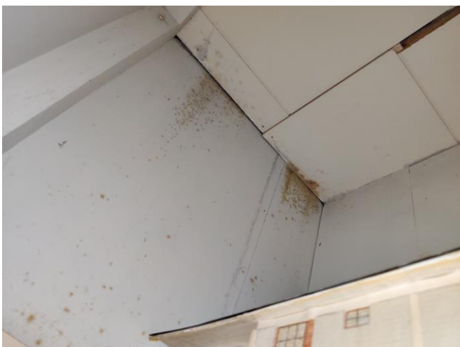
Bild 13. Ytmögel i en förvaringskrubb. (Eget foto)
