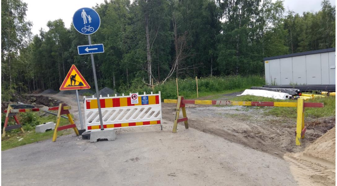
Kuva 4. Työmaa-alueen suojaukset ja liikenteenohjaus
