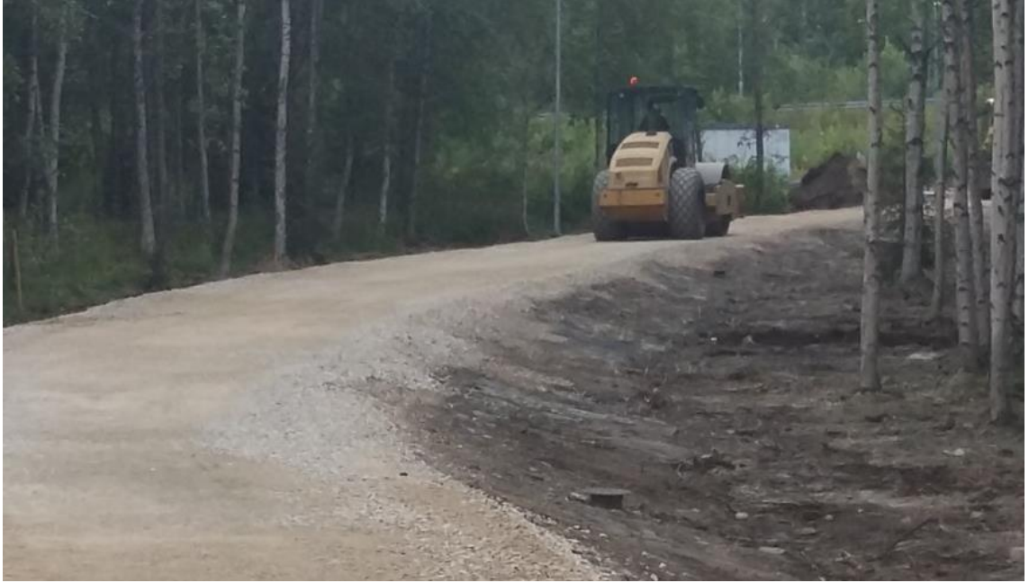
Kuva 11. Kantavan kerroksen tiivistäminen täryjyrällä
