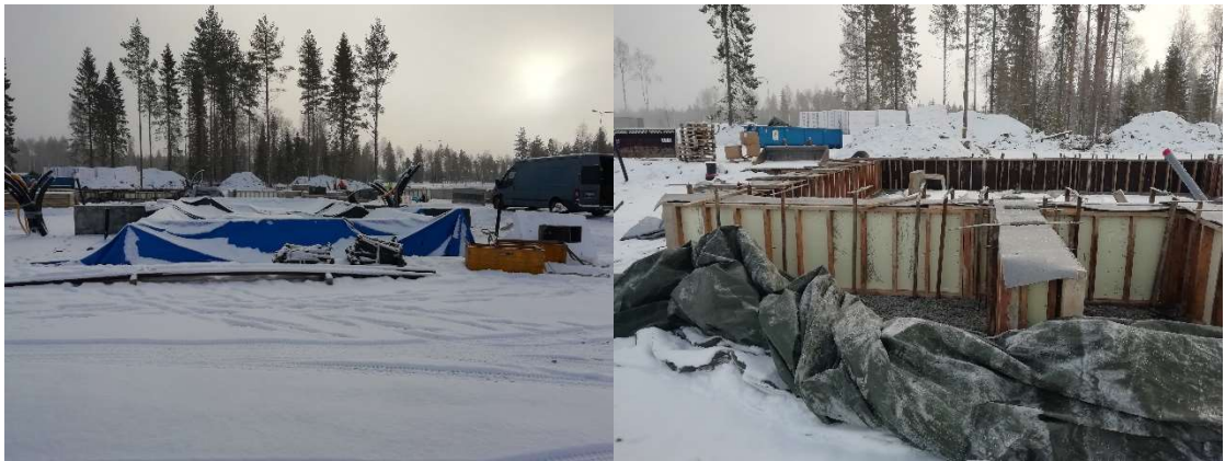
Kuvio 9. Peitetty sokkeli ja eristetyt valumuotit
