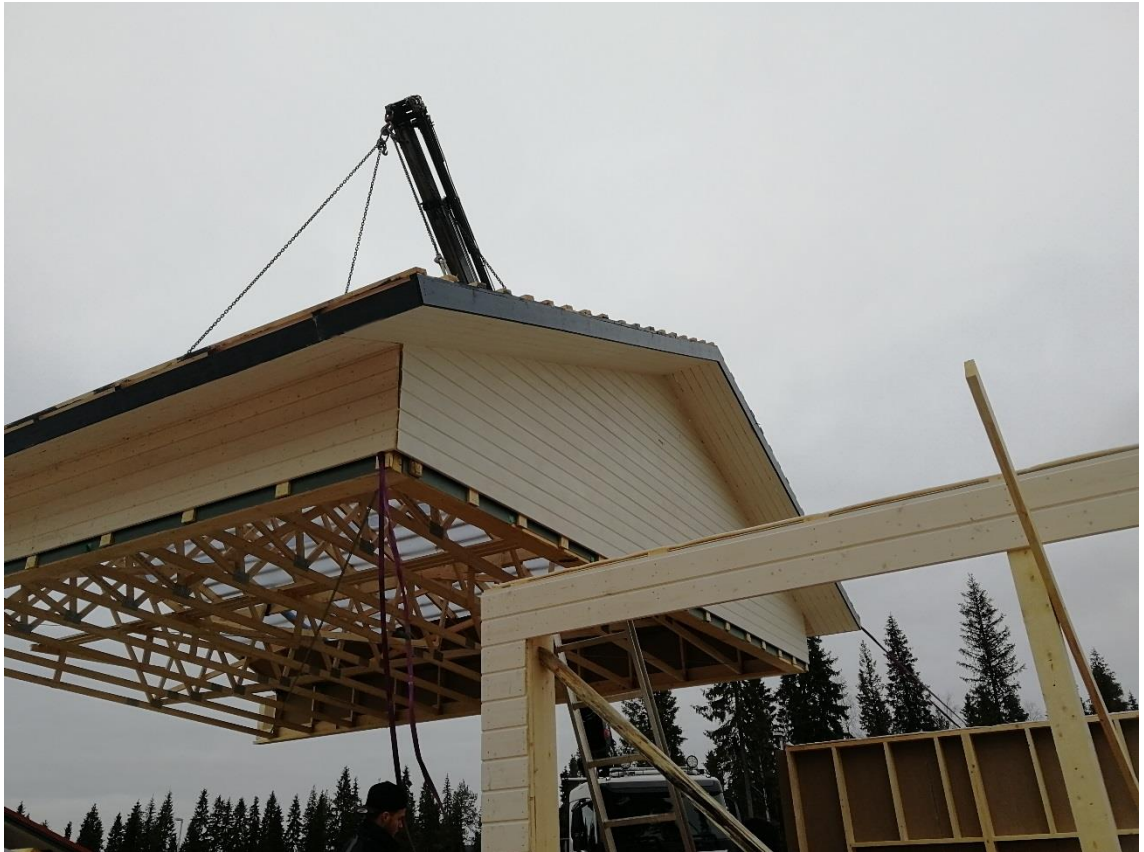
Kuva 11. Katon puolikkaan nosto
