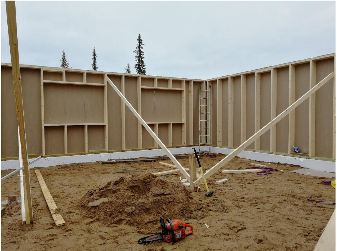
Kuva 10. Elementit revattuna paikalleen
