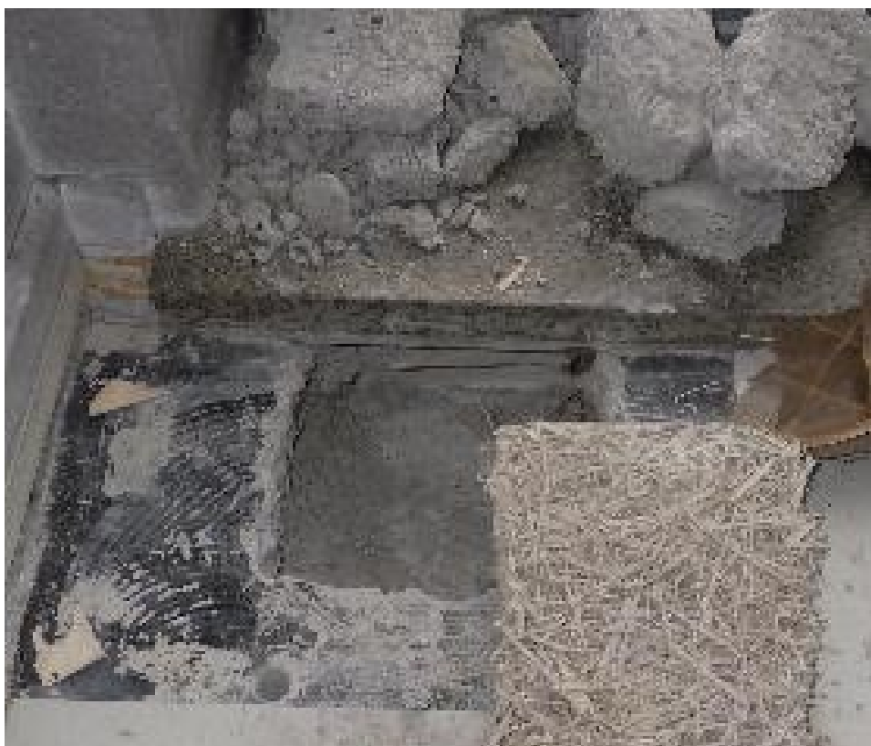
Kuva 12. Rakenneavaus välipohjaan.
