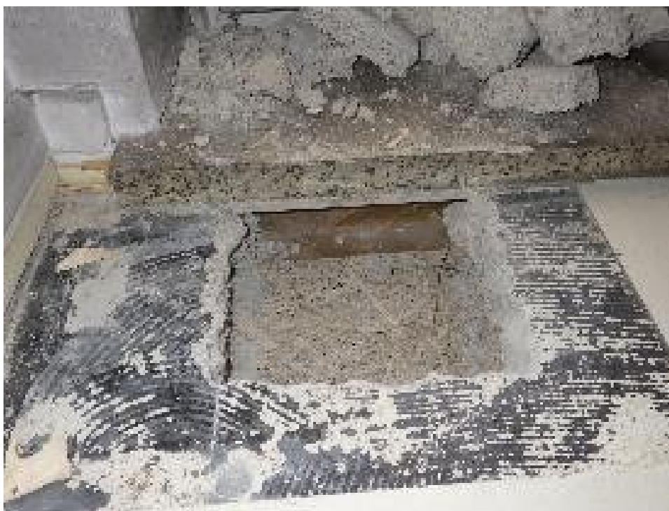
Kuva 11. Rakenneavaus välipohjaan.
