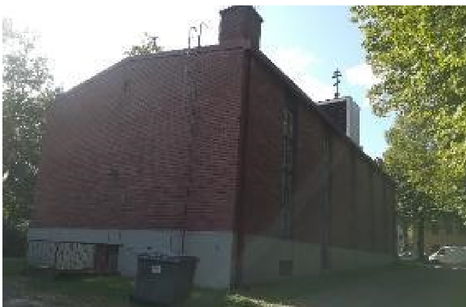
Kuva 4. Kirkkorakennuksen kellarin pääty.
