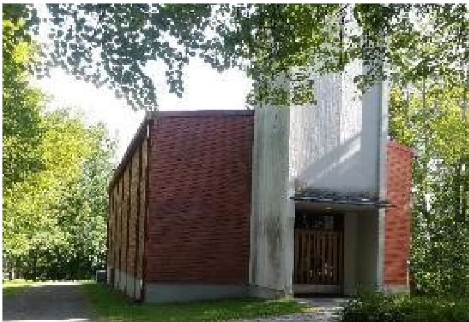
Kuva 3. Kirkkorakennuksen sisäänkäynnin pääty.
