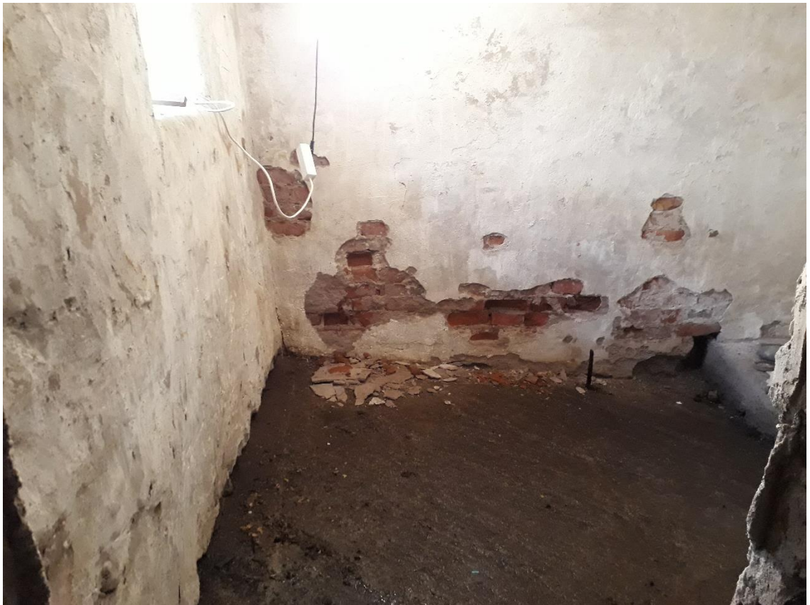
KUVA 05. Kellarin eteläpäädyn suuntainen seinä.
