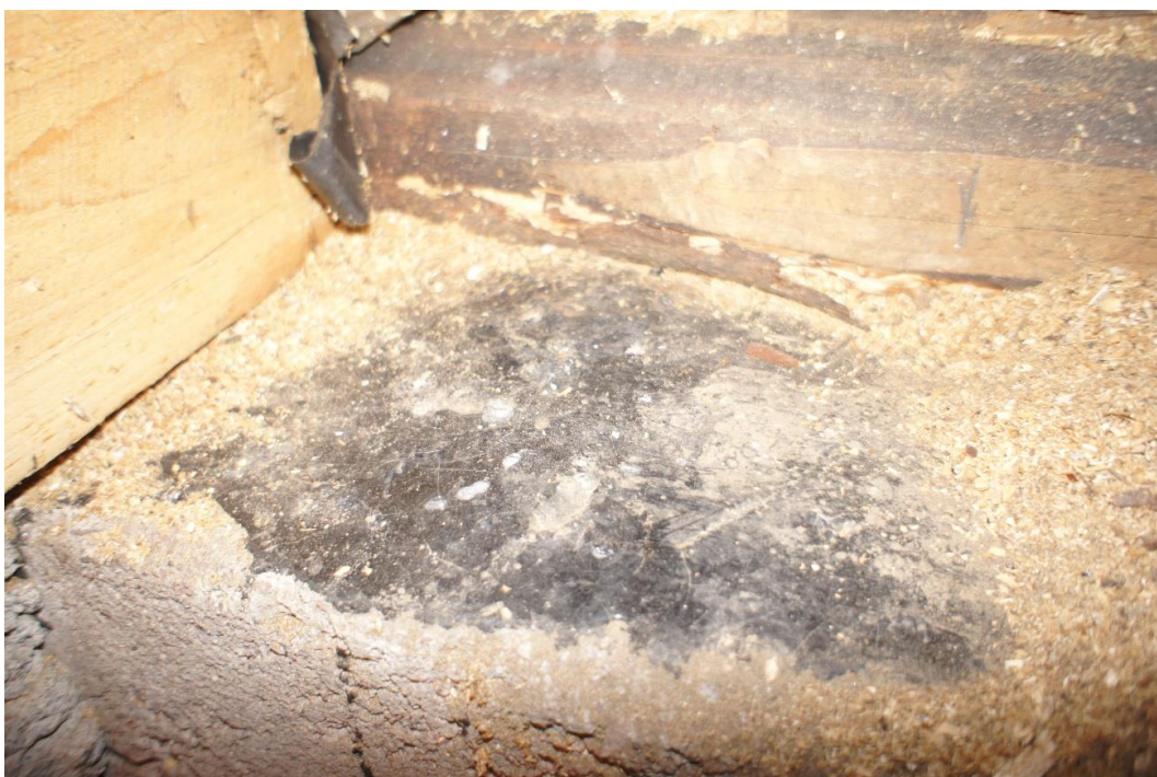
KUVA 17. Puuvaraston takaseinän alueella bitumisively esillä. Laajennusosalla perusmuuri on luonnonkivirakenteinen, mutta sisäpinnalta viimeistelty betonin avulla.
