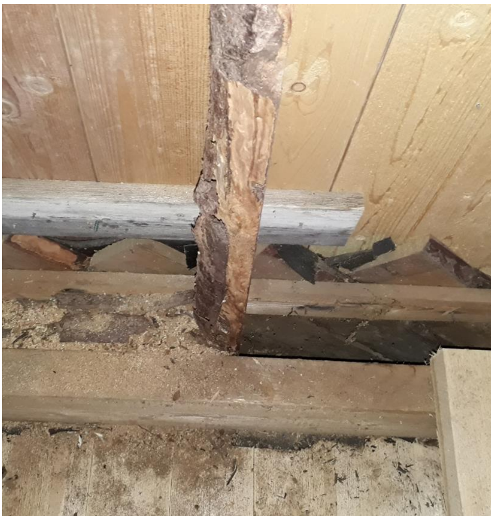
Kuva 18. Ulkoseinärakenne vintin puolelta. Kuvassa runkotolppa, eristetila, vinolaudoituksen yläosa, ja ulkoverhouksen tausta.
