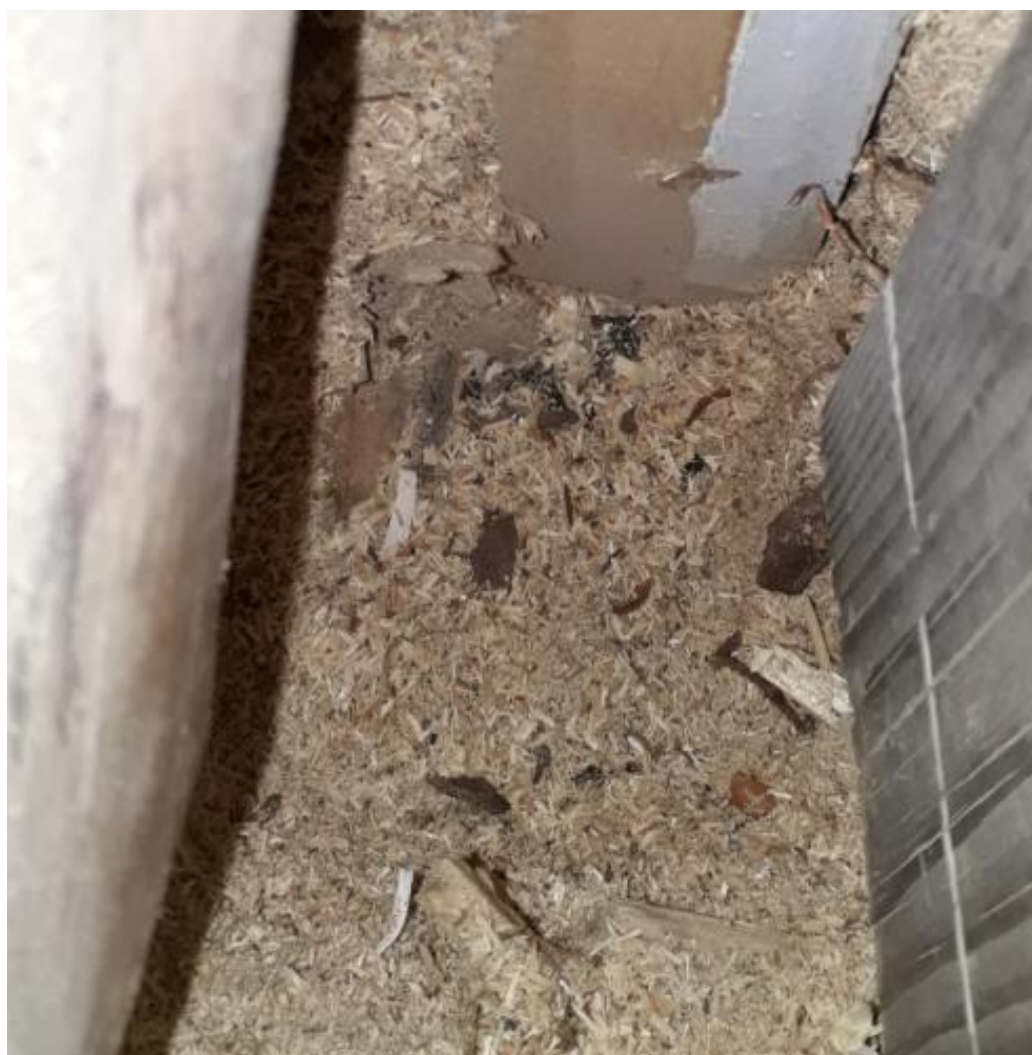
KUVA 13. RA.04.AP Rakenneavaus keittiön alapohjassa, eristekerroksen alla betonilaatta, jonka pinnassa bitumisively.
