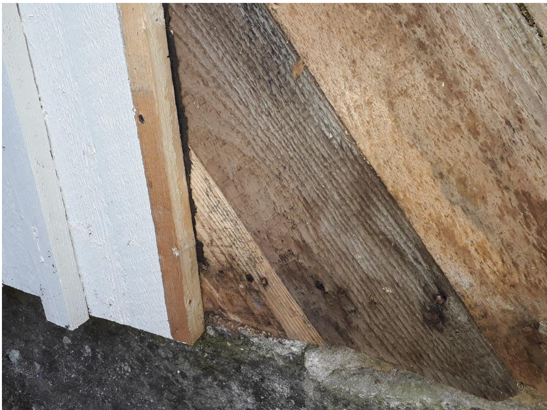
KUVA 16. RA.03 US. Ulkoseinarakenteen alaosa. Bitumivuorauspaperi poistettu vinolaudoituksen päältä.
