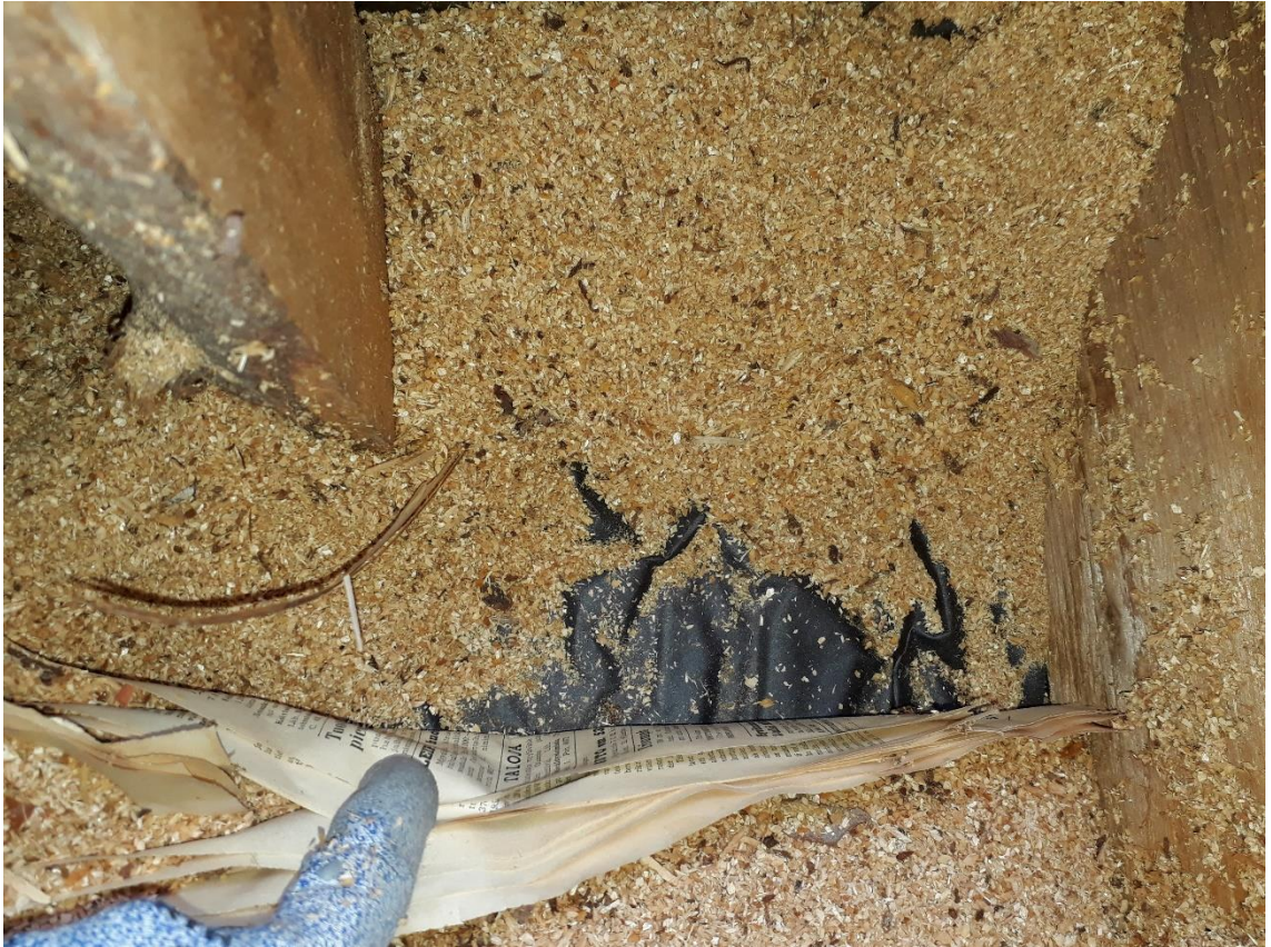
KUVA 26. RA.06.YP. Rakenneavauskohta yläpohjapalkin ja ulkoseinän liittymäkohdassa. Purujen alla sanomalehteä ja tervapaperi.
