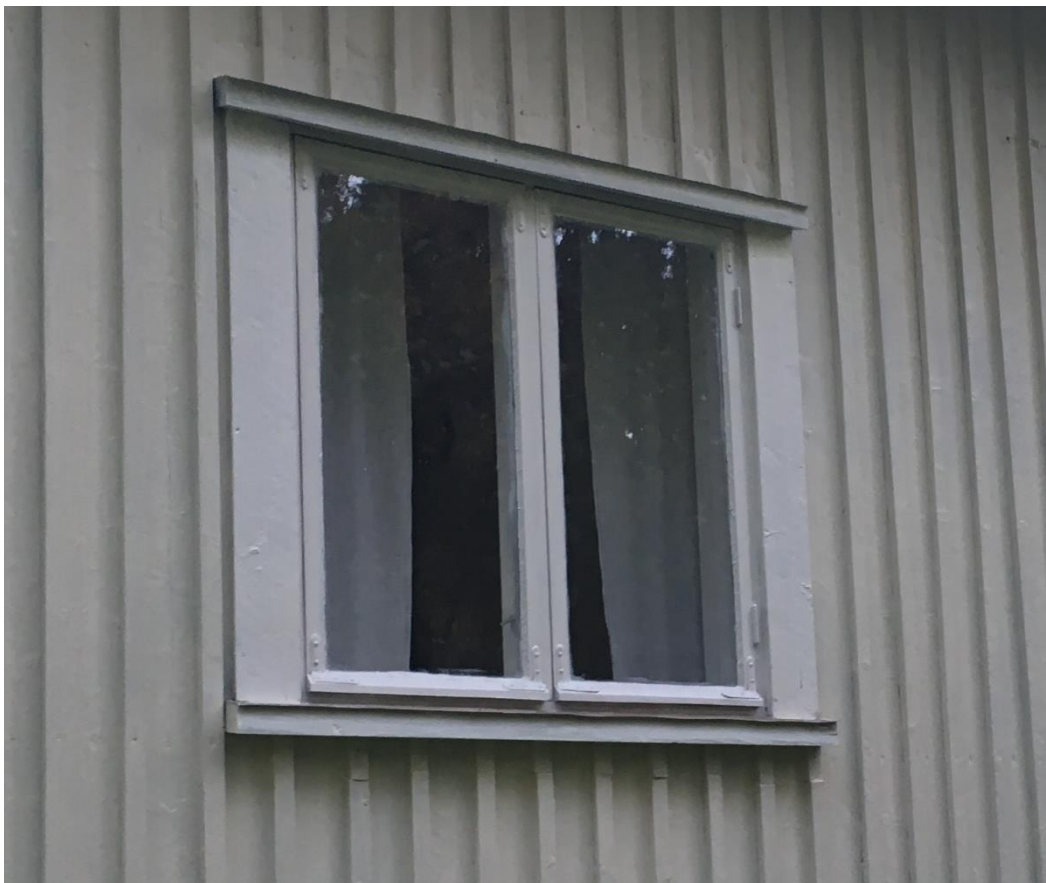
KUVA 19. Alkuperäiset ikkunat on suojattu pellityksin sekä ylä- että alakarmin alueelta.
