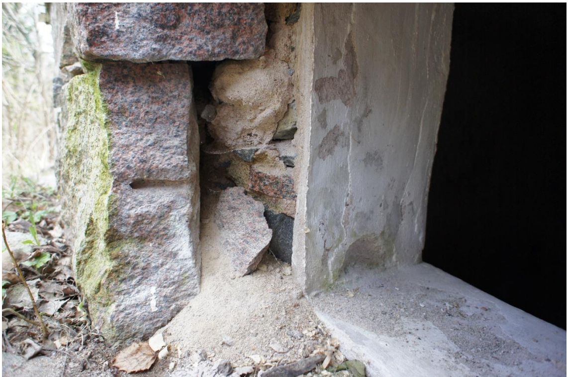
KUVA 04. RA.02.PM Rakenneavaus perusmuurissa kellarin ikkuna-aukon vieressä.
