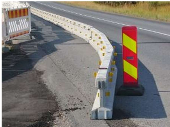
Kuva 4. Rebloc –turvakaide. Valmistajan mukaan mahtuu pieneen tilaan ja antaa suuren suojausluokan (Elpac, 2020).
