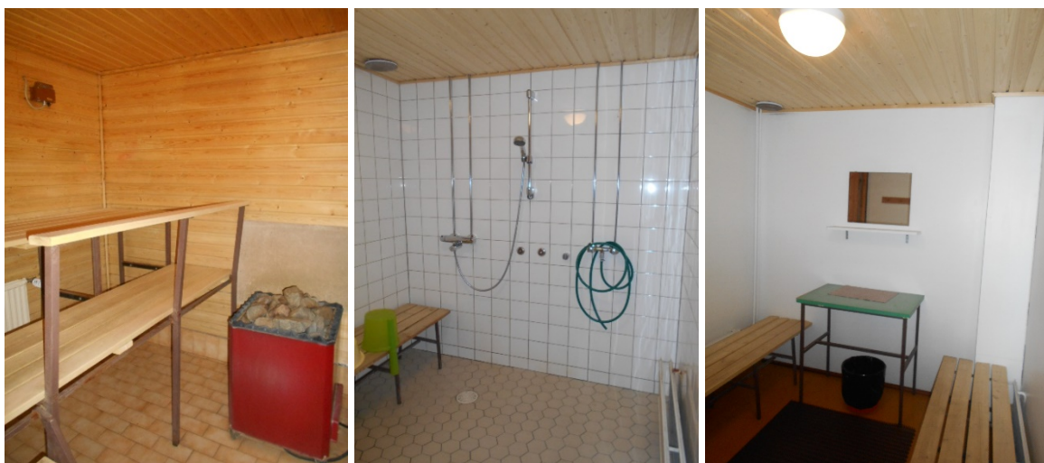
KUVAT 41, 42 ja 43. Sauna, pesuhuone ja pukuhuone (Nieminen 2019)
