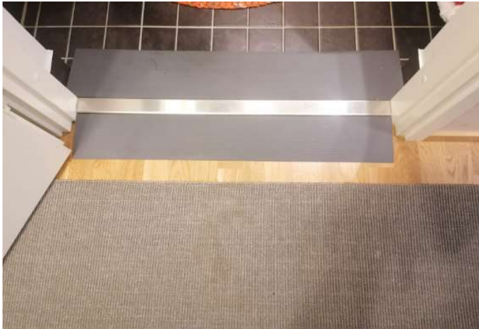
KUVA 14. Kylpyhuoneen kynnys luiskattuna (Alimaa 2019)
