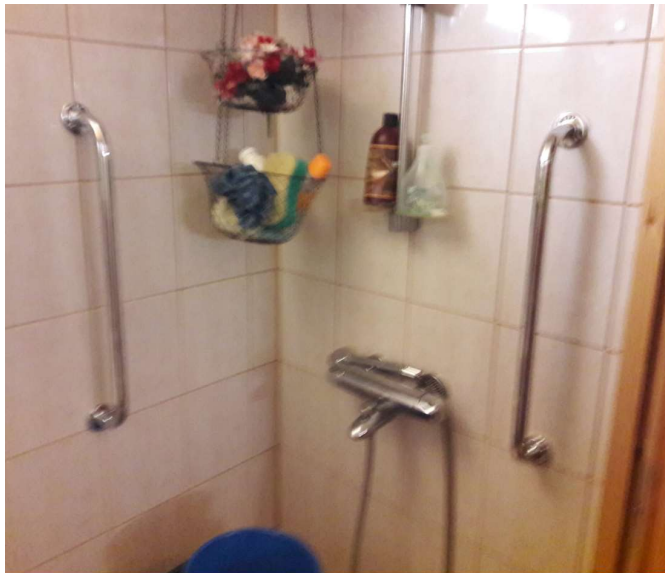
KUVA 3. 400mm kromiset tukikahvat kiinnitettyinä kylpyhuoneessa (Alimaa 2019)
