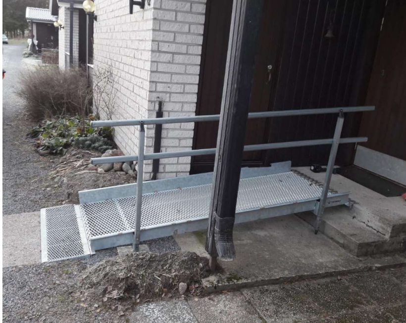
KUVA 20. Teräsluiska asennettuna kohteelle (Alimaa 2019)
