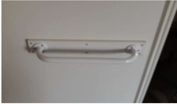
KUVA 4. 300mm valkoinen tukikahva kiinnitetty kylpyhuoneen oveen, jossa vahvistus on tehty iki-levyllä (Alimaa 2019)
