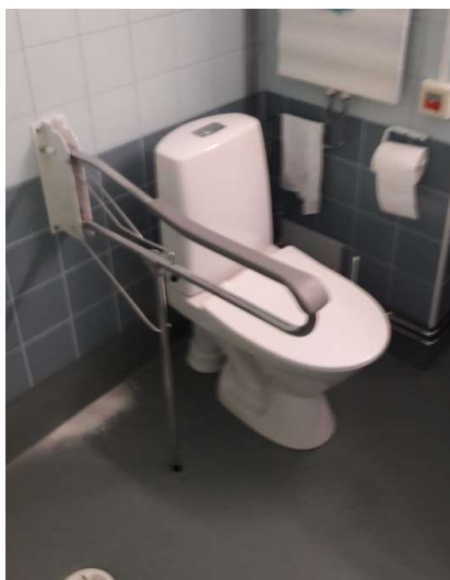
KUVA 5. Seinään kiinnitettävä tukikaide, lisäjalalla. Kaiteet lukkiutuvat sekä ala- että yläasentoon (Alimaa 2019)
