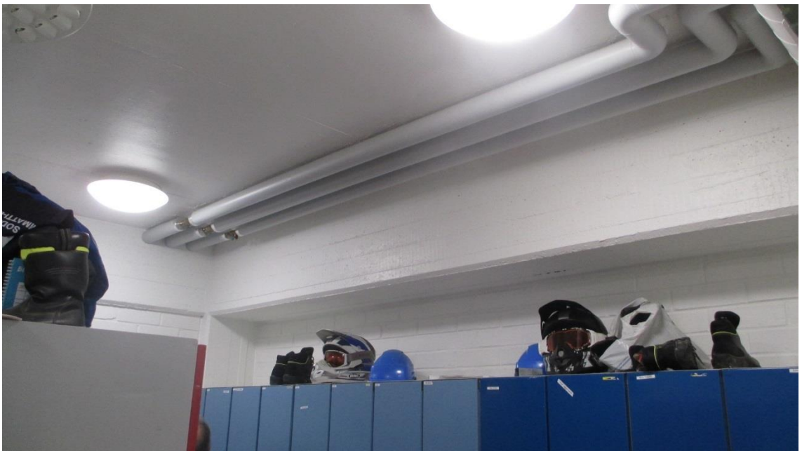
Kuva 9. Saneerattuja vesijohtoja pukuhuonetilassa
