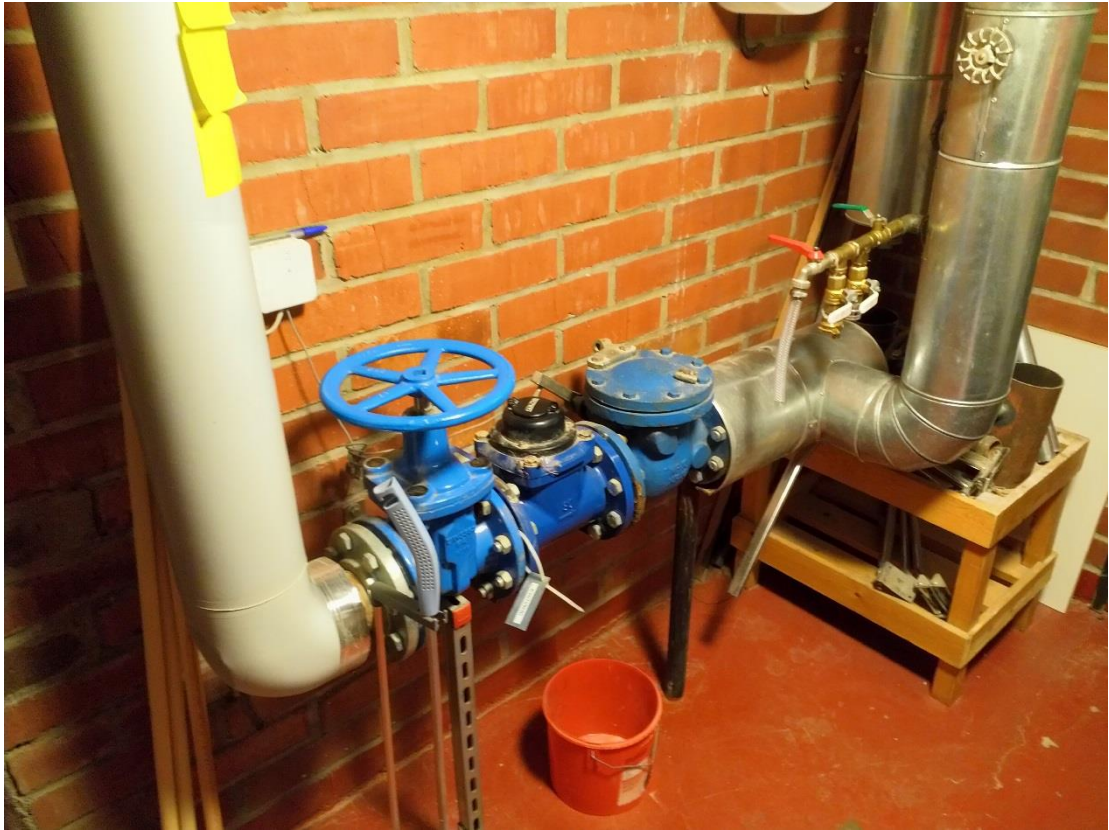
Kuva 3. Aikaisemmin saneeratun vesijohdon urakkaraja saatiin tarkennettua vesimittariin kohdekäynnin ansiosta
