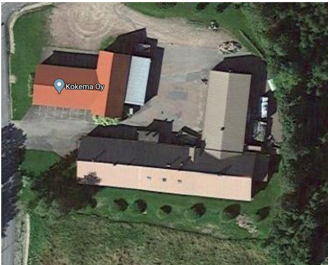
Kuva 1. Satelliittikuva Kokeman rakennuksista (Google-maps www-sivut 2020).
