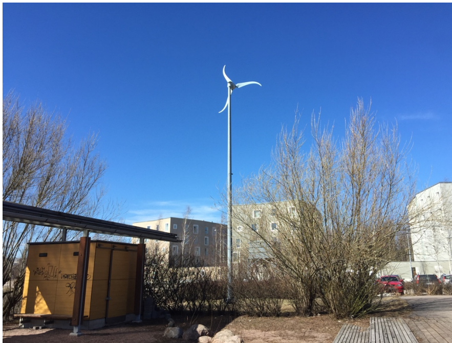
Figur 3. Vindkraftverket "Viikkeri" står i Vik i Helsingfors och matar ut den producerade energin direkt i stadens elnät. Vindkraftverket är av modell SkyStream 3.7 från USA, har en toppeffekt på 2,4 kW och navhöjden 12 m. Fotograf Robert Toivanen.
