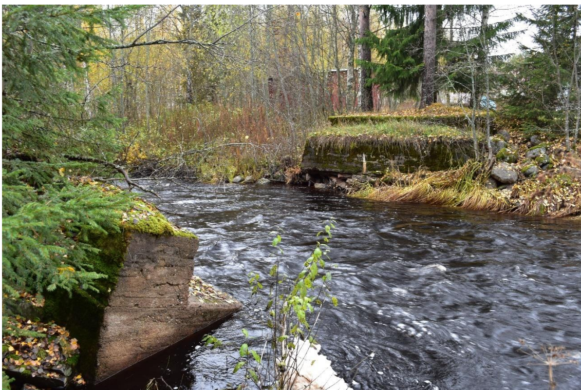
Kuva 39. Rauanjoki 77 kosken niska ja vanhat sillan perustukset Rauanjoen alaosassa Ruvaslahdentien sillan pohjoispuolella 13.10.2019 (Kuva: Henri Heiskanen).
