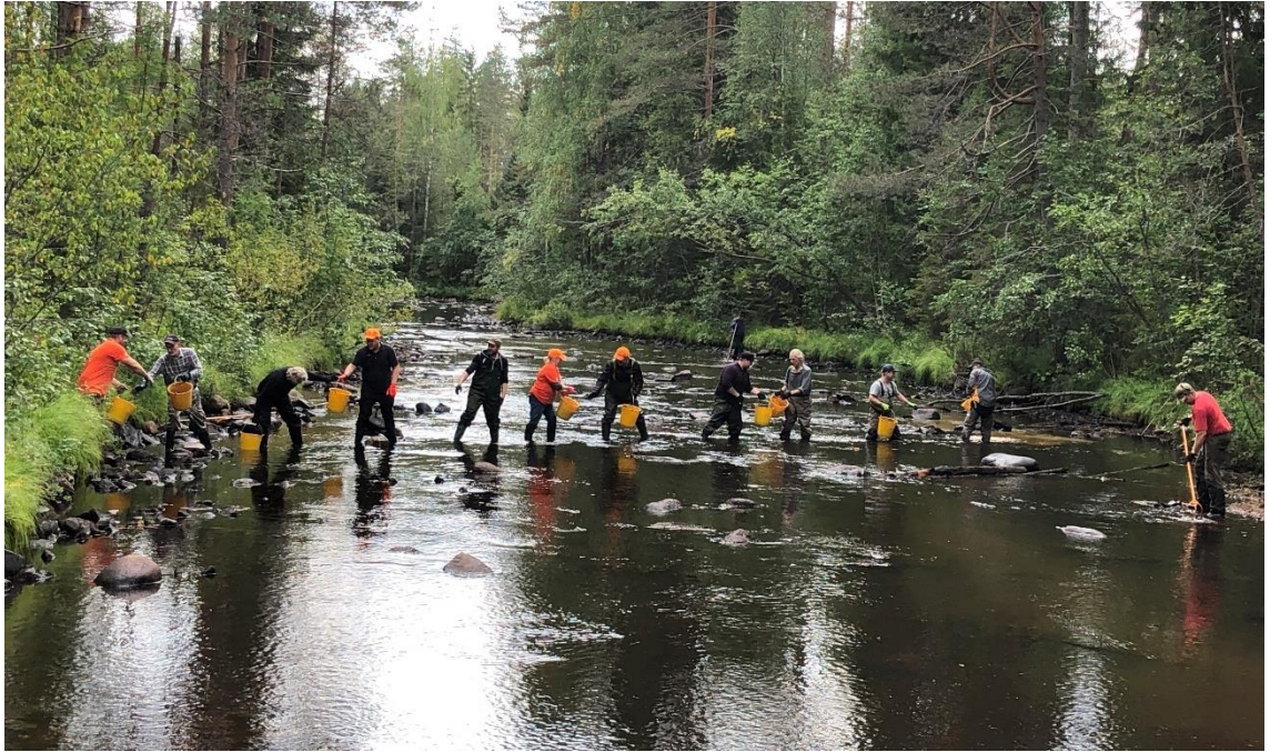
Kuva 9. Talkoovoimin tapahtuvaa virtaveden kunnostamista Rauanjoella syksyllä 2019. Koskipaikkaa kunnostettiin muun muassa kiveämällä ja kutusoraikoita tekemällä (Kuva: Kirsi Karhio).
