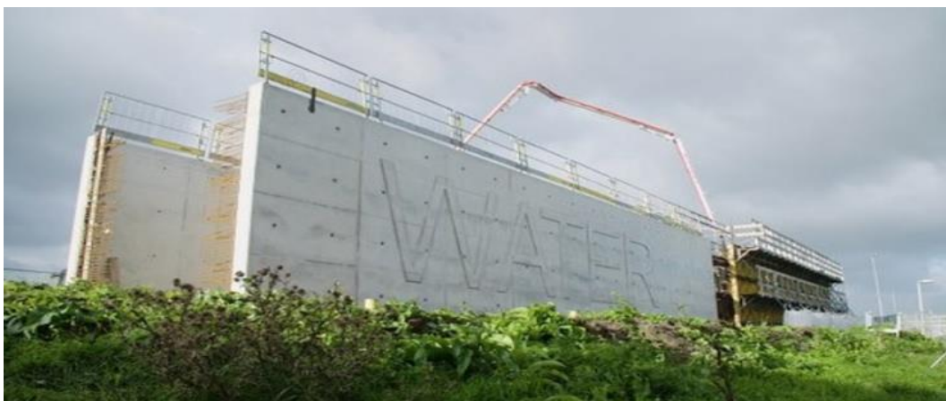
Kuva 23. Osittain itsekorjautuvasta betonista valmistettu vesisäiliö Rotterdamissa. /38/
