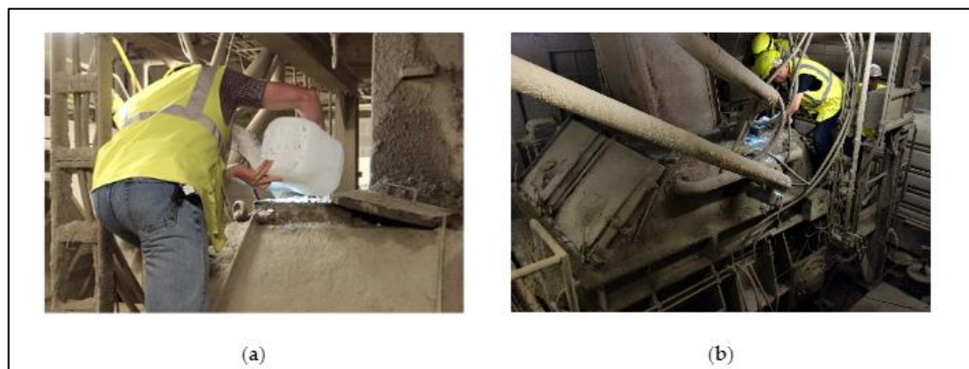
Kuva 20. Bakteerien, sekä ravinteiden lisäys betonimassaan tarkistusluukun kautta. /35/
